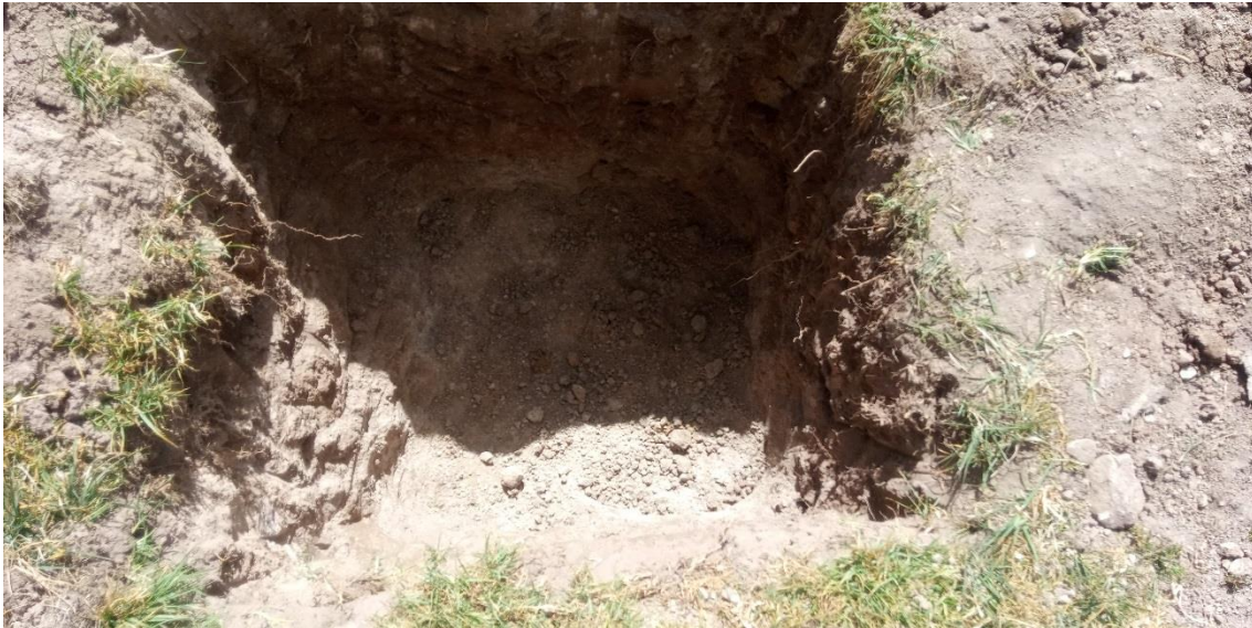
Imagen 12: Cuadro de paredes de la calicata C-3
