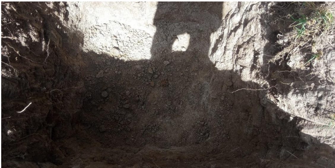
Imagen 13: Fondo de calicata C-3
