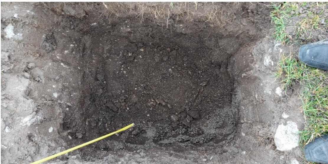
Imagen 3: Cuadro de paredes de la calicata C-1
