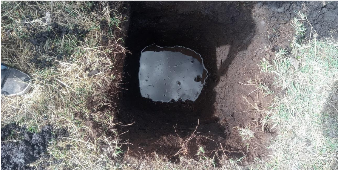
Imagen 4: Fondo de calicata C-1
