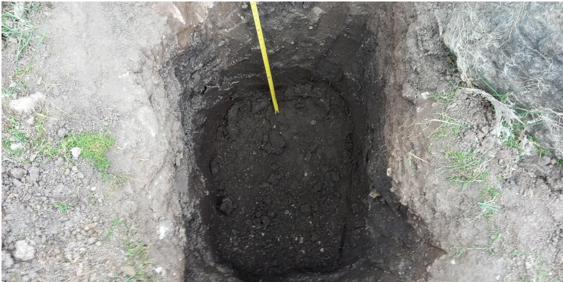
Imagen 8: Fondo de calicata C-2
