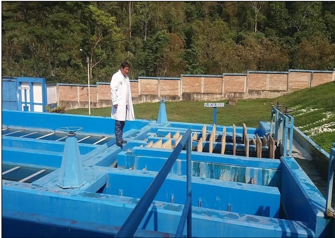
Figura 3. Decantadores de flujo laminar de floculadores
