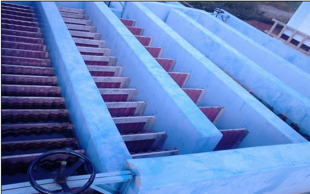
Figura 13. Floculador de flujo horizontal
