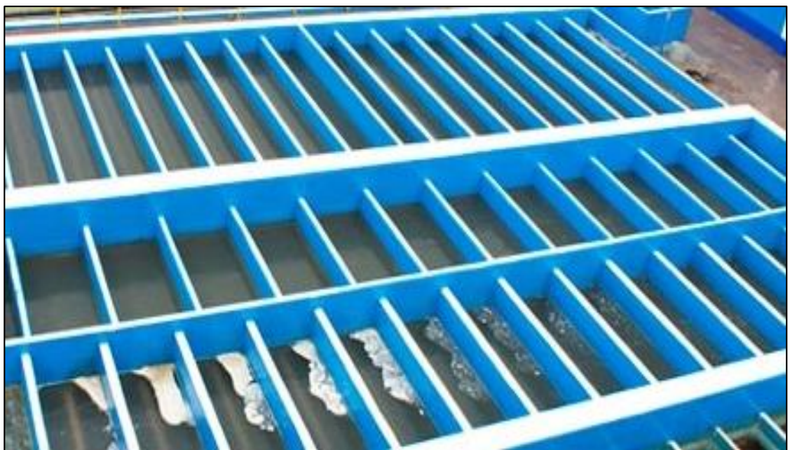
Figura 19. Floclador de flujo horizontal
