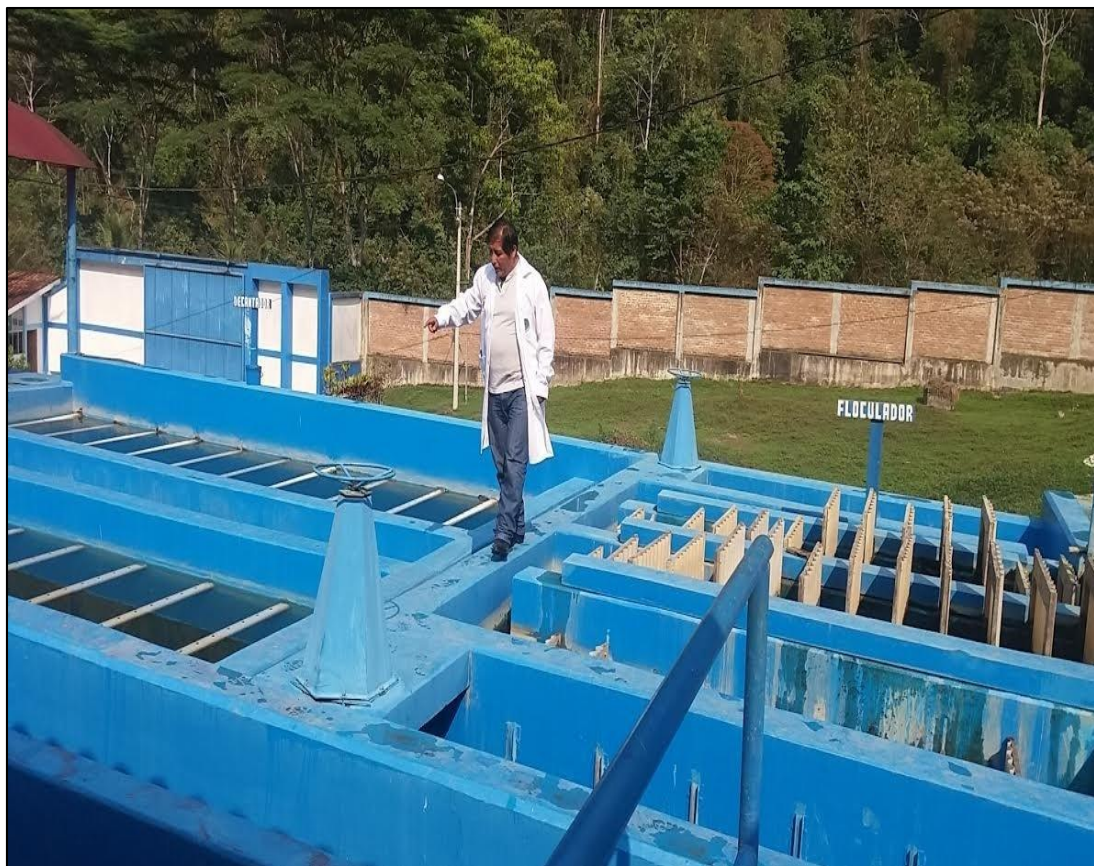
Figura 4. Decantadores de flujo laminar horizontal
