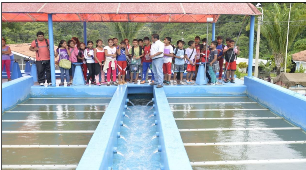
Figura 20. Decantadores lamelares
