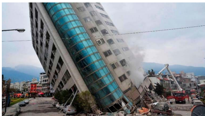
Fig. 5 Edificio colapsado a causa del terremoto en Taiwán.
