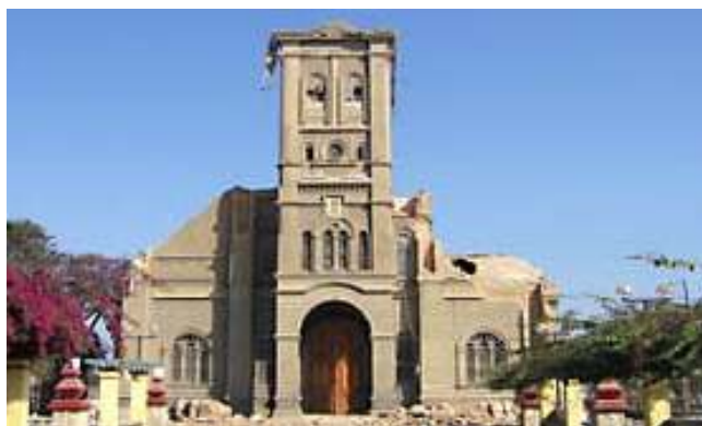
Fig. 10 Después del terremoto en Ica - Perú 2007.
