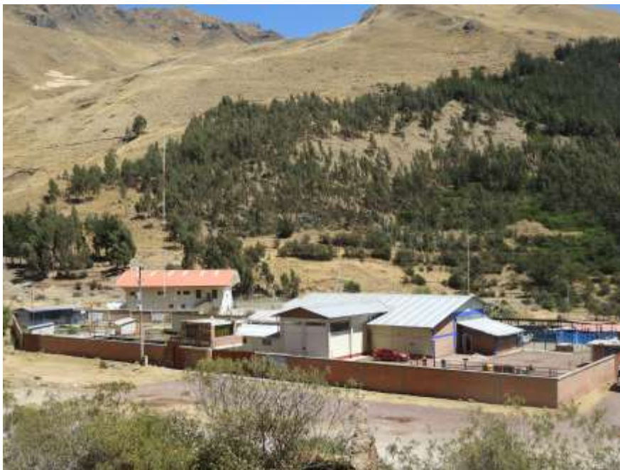
Anexo 1. Vista panorámica del Camal Municipal de Huancavelica, lugar donde se obtuvo fetos de alpaca, 2024.
