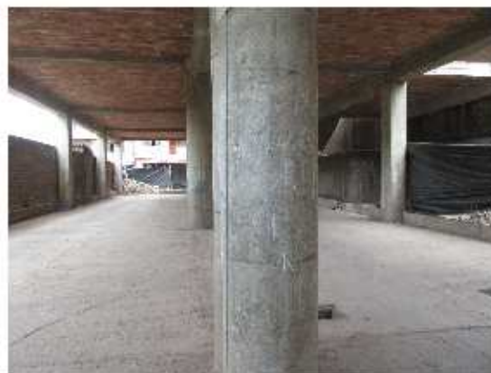
(b) Vista del 1er nivel del mercado
