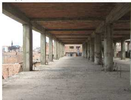
(d) Vista del 3er nivel del mercado
