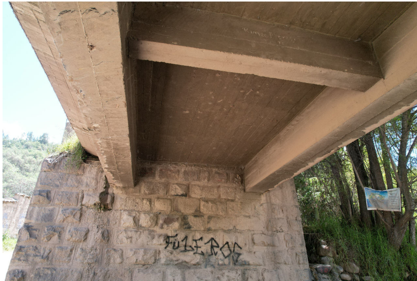
Figura C.5 Vigas y Diafragma.
