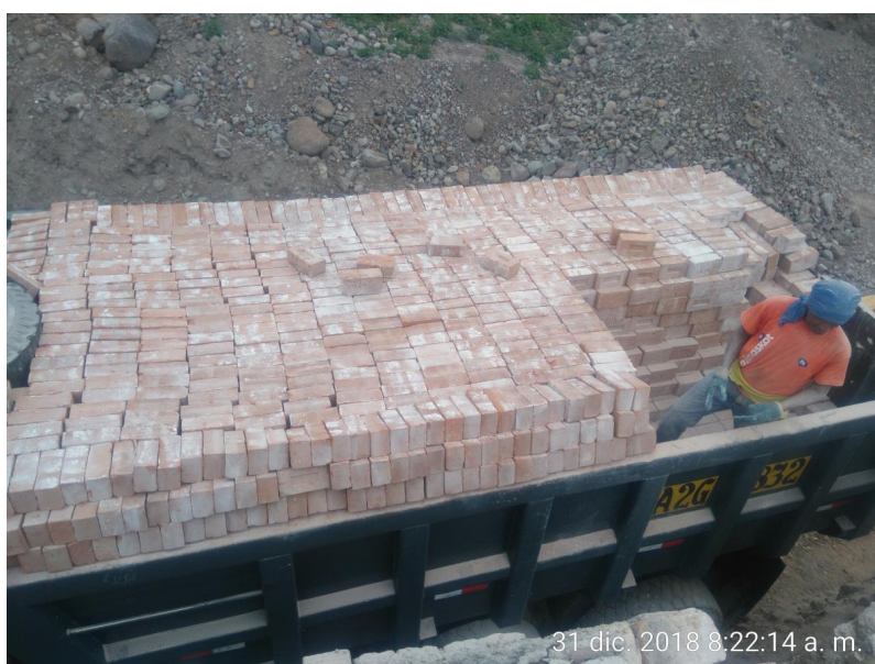
Figura 37 Proceso de selección, descarga y almacenamiento. Fuente: Elaboración propia
