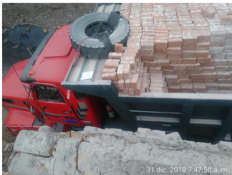
Figura 36 Proceso de selección, descarga y almacenamiento. Fuente: Elaboración propia
