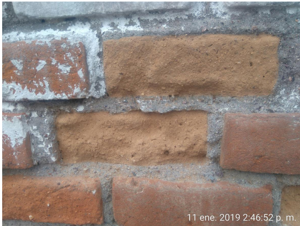
Figura 3 Porosidad en las unidades de albañilería. Fuente: Elaboración propia
