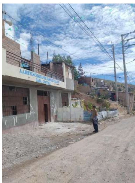
Fotografía 4: Registro de la foto de fachada en el aplicativo gis por cada cliente
