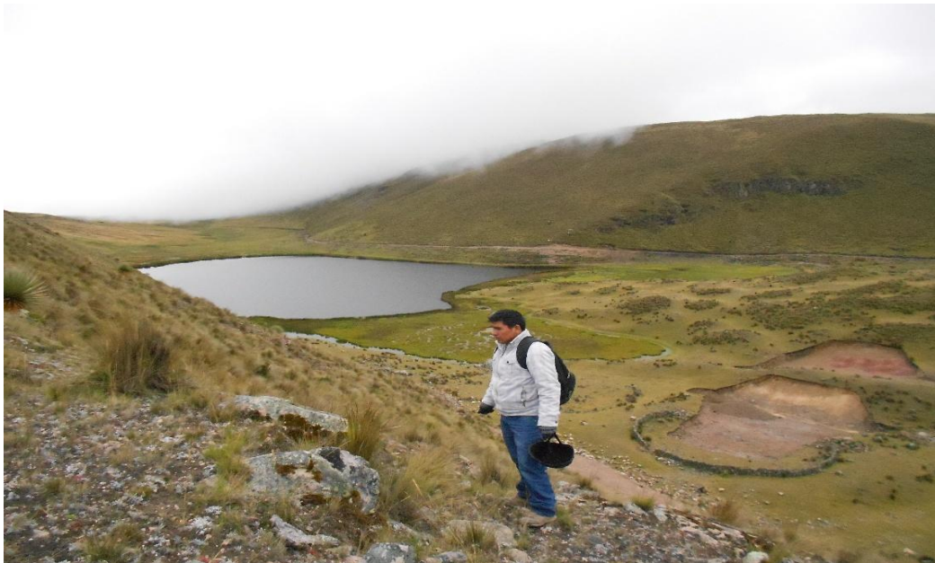
Figura A.2 Vista de la presa de Tantar desde el lado izquierdo, la característica de las rocas, excavación de diques
