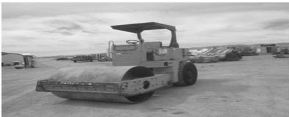
Figura Nº 1.23 maquinarias rodillo en proceso de compactación Fuente: Recopilación de simposios 2004.
