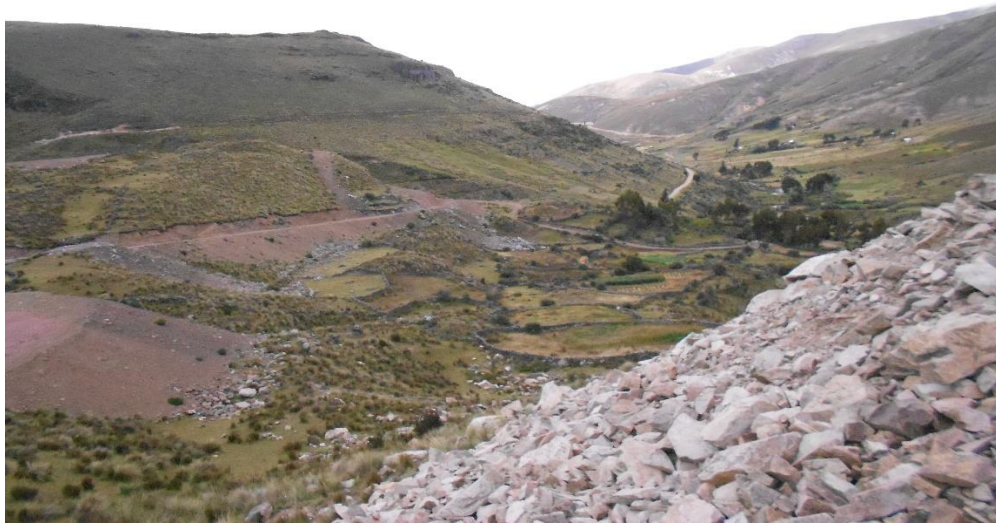
Figura A.5 Vista desde parte alta de la presa, hacia aguas debajo, para evaluación de poblaciones en caso de falla de presa.
