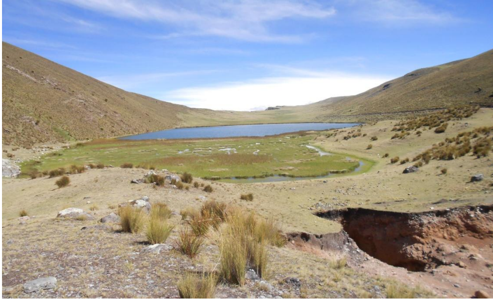
Figura A.3 La presa vista desde aguas abajo, se muestra final de la cuenca a 200 m. aproximadamente desde la presa, características del suelo.
