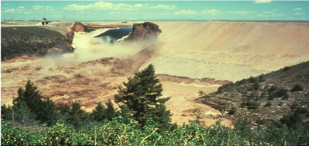
Figura Nº A.1 Asentamiento del suelo y filtraciones por debajo de la presa 1973 EE. UU. Presa Tetón, el núcleo era poco plástico: presentó erosión del suelo subyacente, asentamiento del suelo y filtración, las filtraciones por debajo de la presa se detectaron por primera vez el 3 de junio de 1976.
