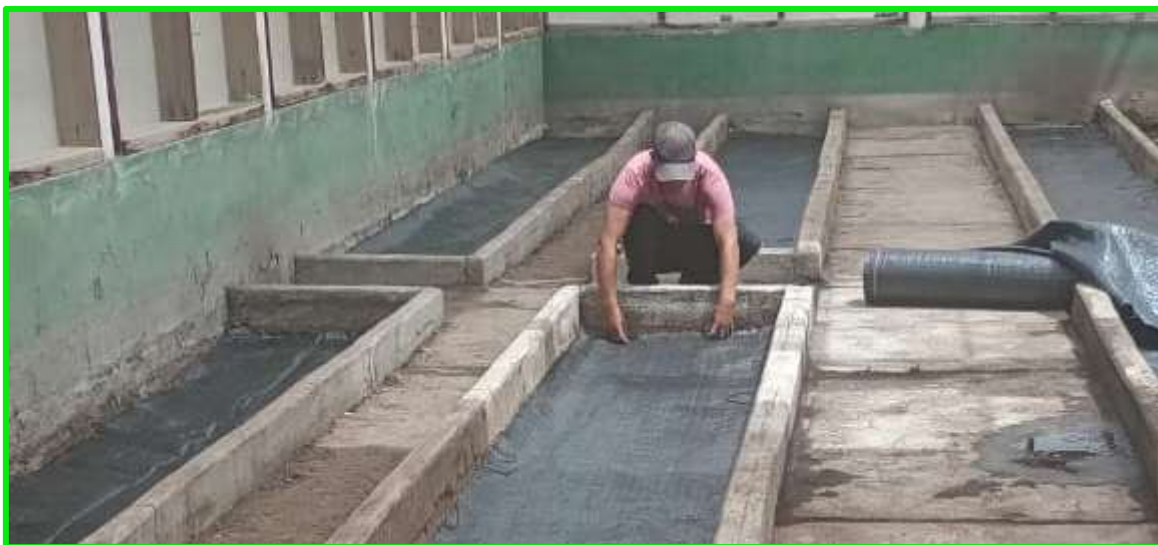
Foto 4. Incorporación de plástico a la base de las camas
