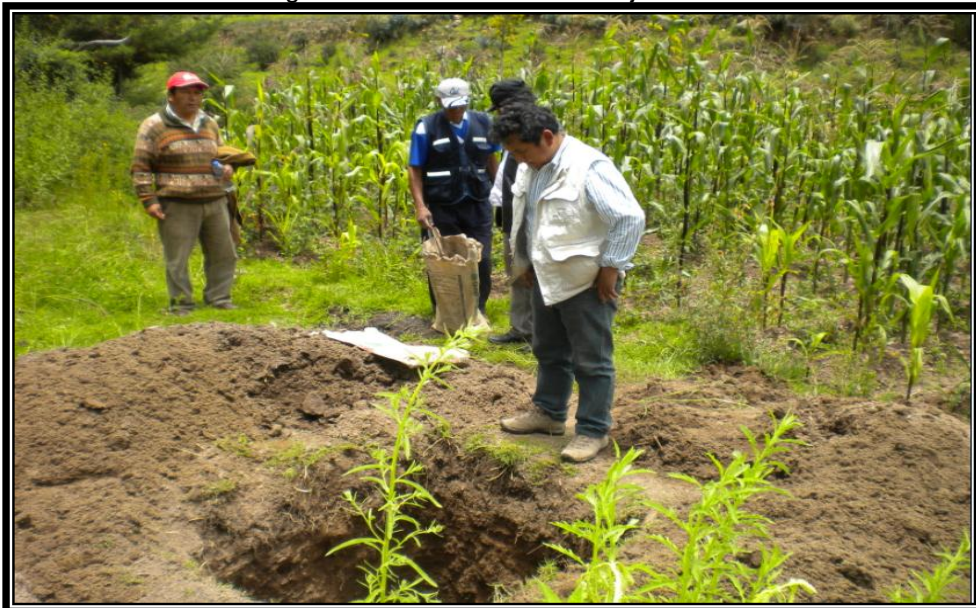
Vista fotográfica de calicata N° 01 para planta de tratamiento
