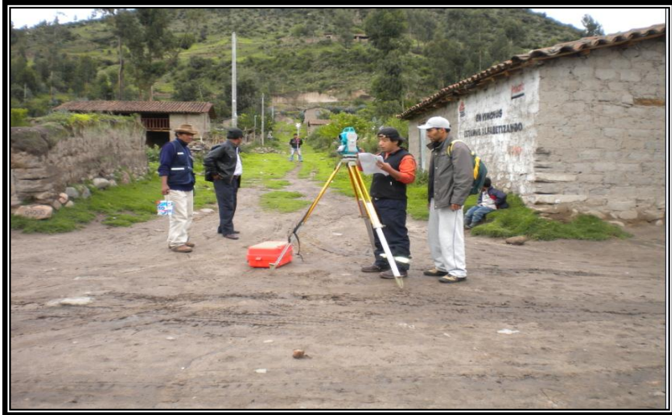
Vista topográfico de levantamiento
