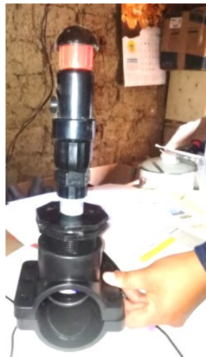
Figura 9: Colocación de válvula de aire
