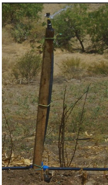
Figura 2.20: Instalación de aspersores en la parcela en estudio
