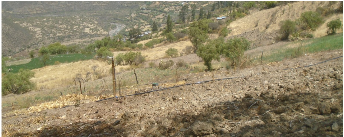
Figura 2.18: Tendido de tubería HDPE en la parcela en estudio de diferentes diámetros
