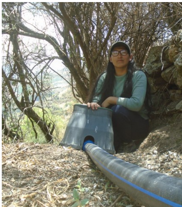
Figura 10: Arqueta de protección de la válvula parcelaria
