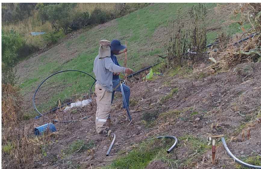
Figura 11: Tendido de tubería HDPE en los laterales de sistema de riego
