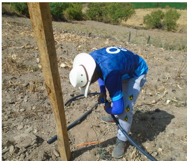
Figura 7: Instalación de accesorios
