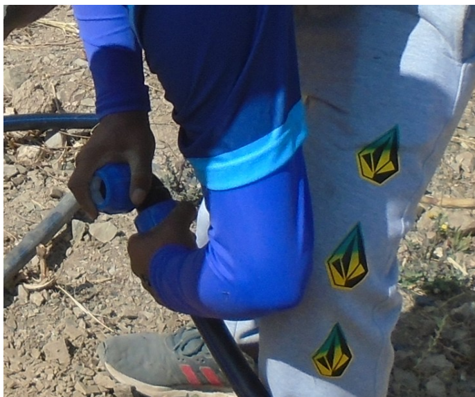
Figura 2.19: Colocación de accesorios del sistema de riego
