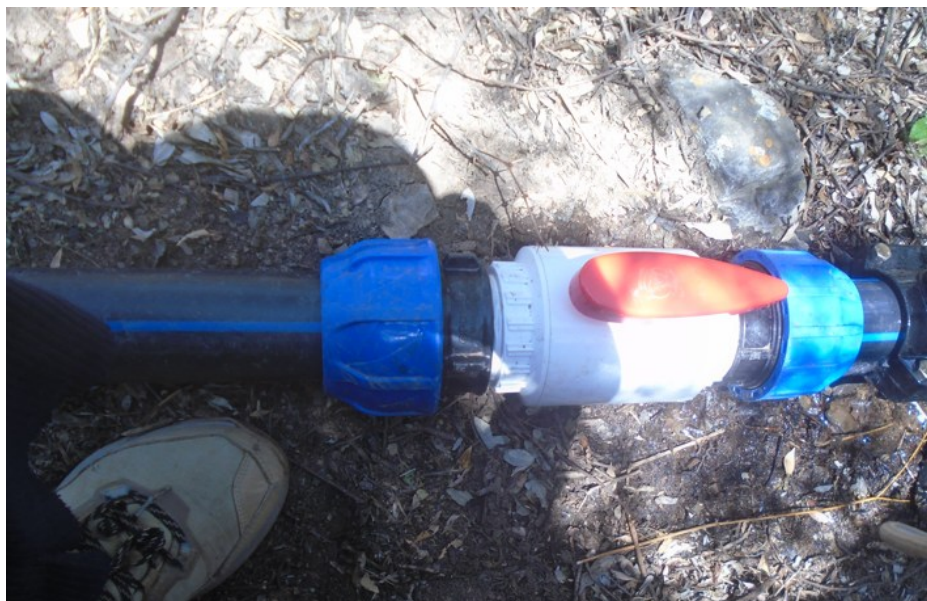
Figura 6: Instalación de válvula parcelaria
