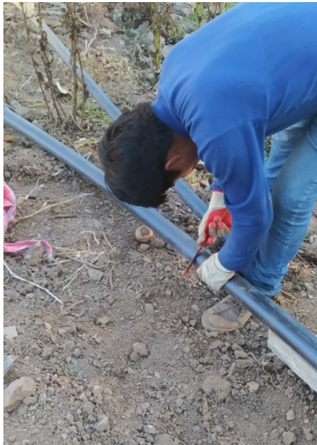
Figura 8: Corte de tubería HDPE con para cambio de dimensionamiento
