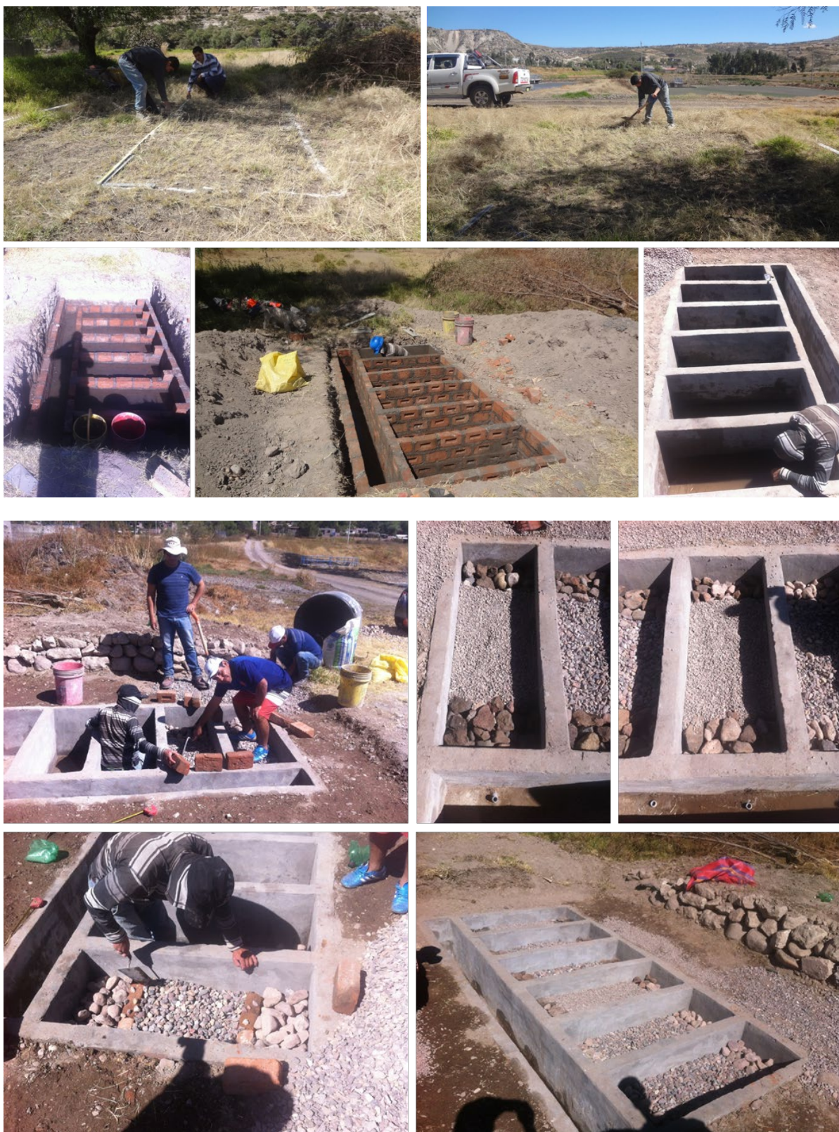
Fotografías N° 03. Superior indica el trazo, replanteo, excavaciones y proceso constructivo de los Humedales Artificiales de Flujo Subsuperficial Horizontal - HAFSSH; Inferior, indica la colocación y distribución del sustrato con piedra de Ø 2" (extremos), gravas de Ø 1/4", Ø 1/2", Ø 3/4" (parte media del humedal), en la poza de descarga o evacuación se ve la tubería PVC SAP de Ø 1/2" lugar de puntos de muestreo.
