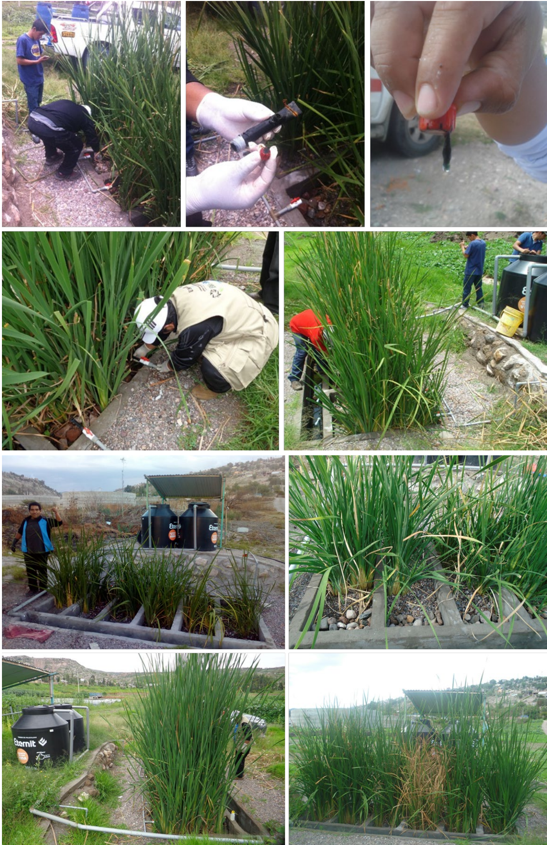
Fotografías N° 05. Indica la operación, monitoreo y manejo de los humedales y así evitar obstrucciones y entaponamientos en goteros; además, del llenado de los tanques cisterna.
