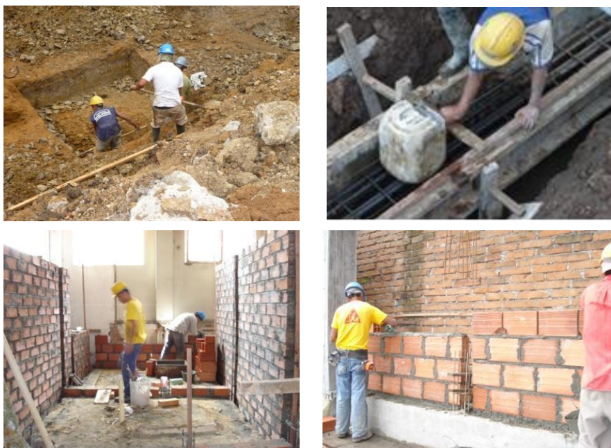
Figura 6. Proceso constructivo de una edificación.
