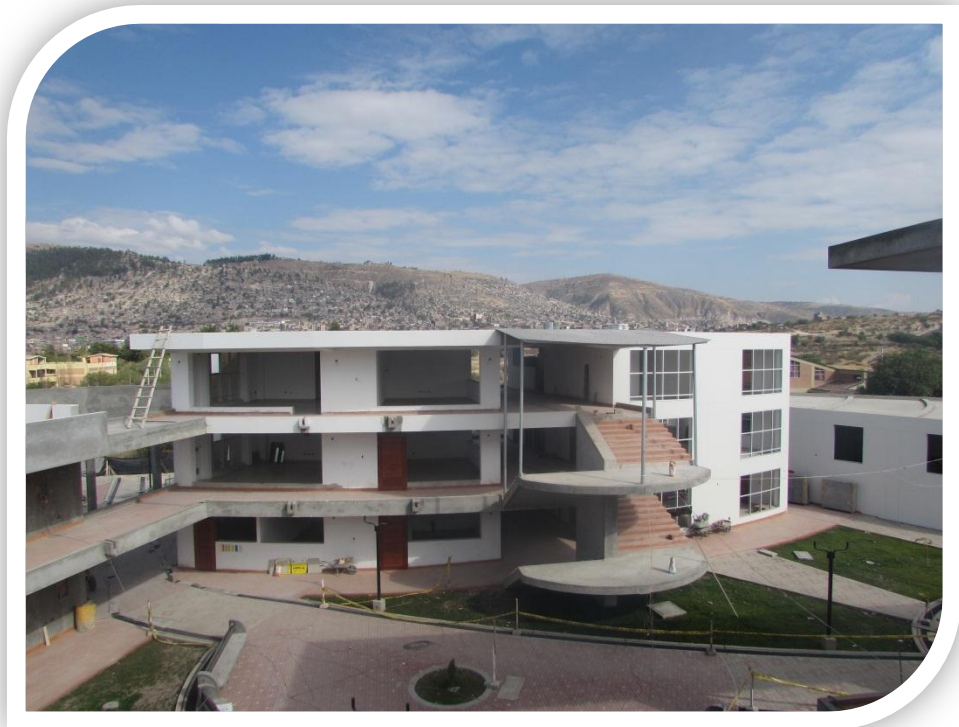
Fotografía 02. Frontis del pabellón de Oficinas Administrativas de la Escuela de Formación Profesional de Ingeniería Civil.
