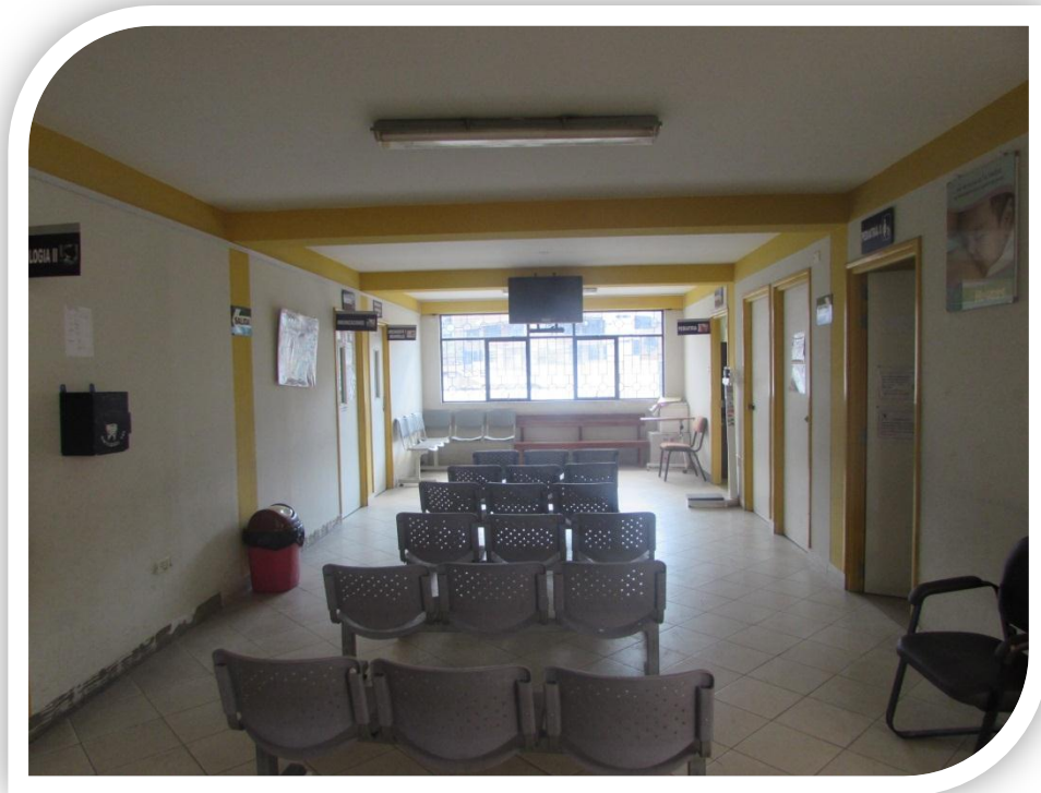
Fotografía 10. Nótese la tipología aporticada con muros de fibrocemento en el interior del pabellón de Consultorios Externos del Hospital Regional de Ayacucho – 2do. Nivel.
