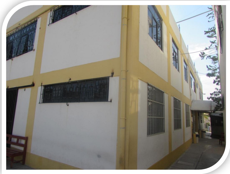
Fotografía 07. Vista lateral izquierda del frontis del pabellón de Consultorios Externos del Hospital Regional de Ayacucho.
