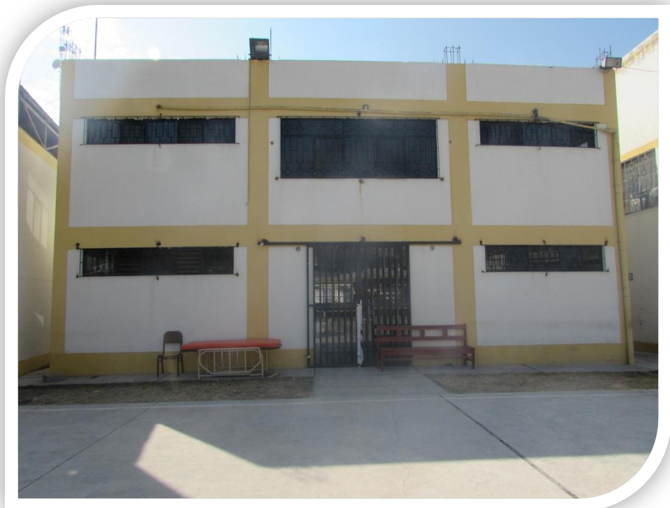
Fotografía 08. Vista lateral izquierda del pabellón de Consultorios Externos del Hospital Regional de Ayacucho.
