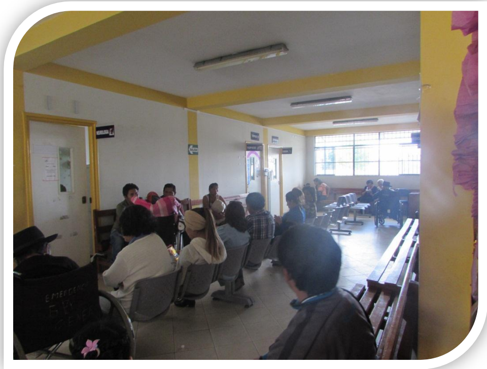
Fotografía 11. Nótese la tipología aporticada con muros de fibrocemento en el interior del pabellón de Consultorios Externos del Hospital Regional de Ayacucho - 1er. Nivel.
