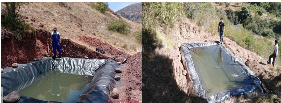
Prueba Hidráulica del microreservorio
