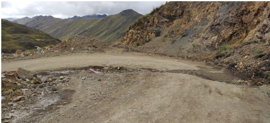
Figura 17. Típica deformación de la curva de volteo
