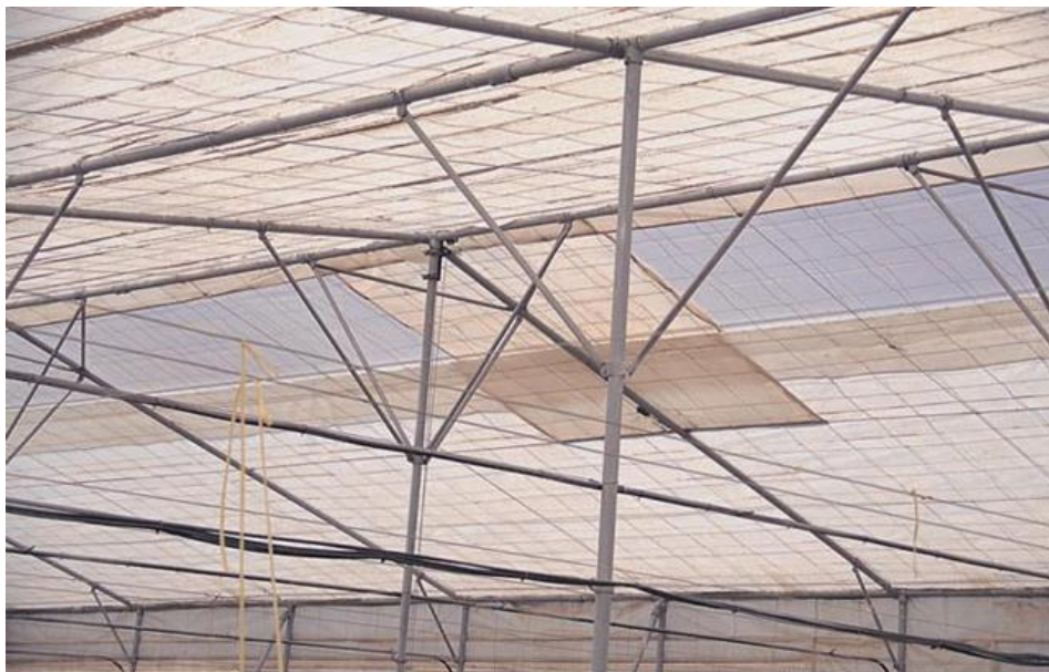
Figura N° I.13: Ventilación cenital estructura
