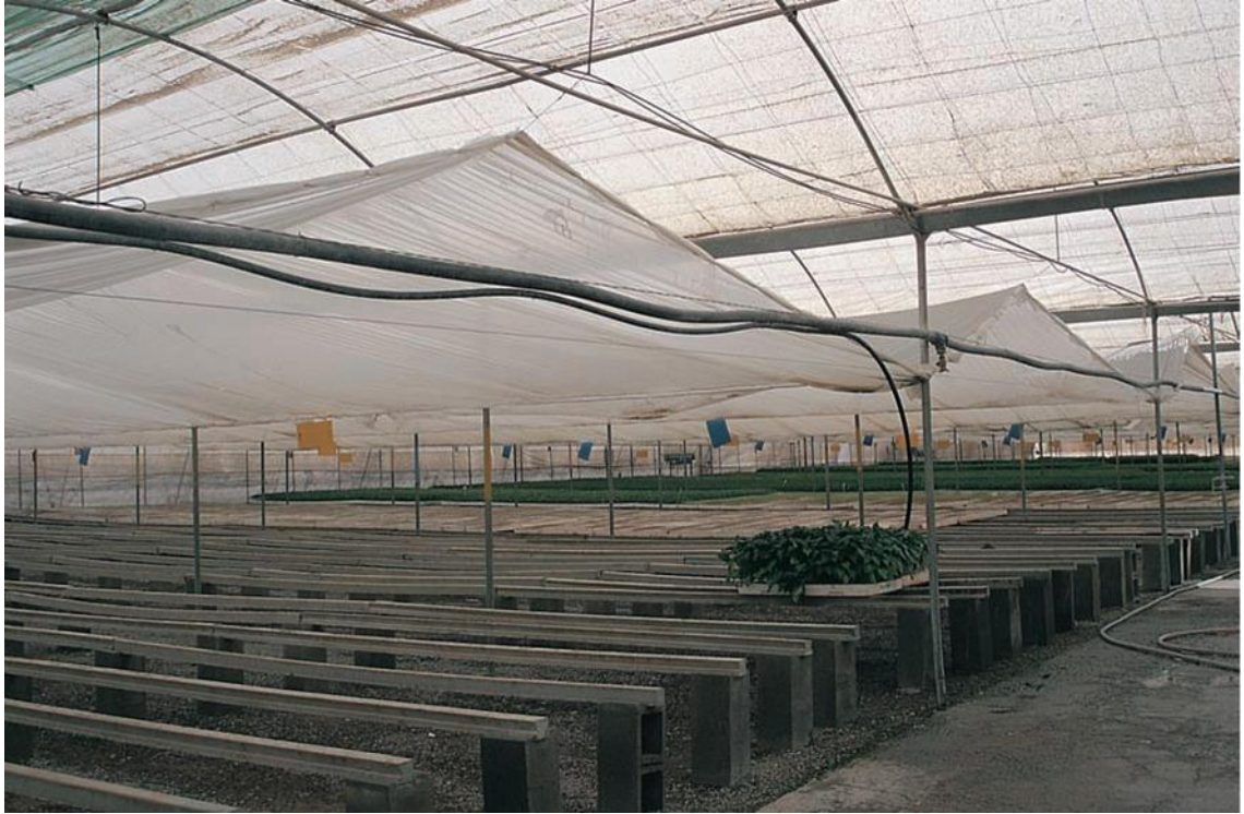
Figura N° I.10: Colocación de un doble techo
