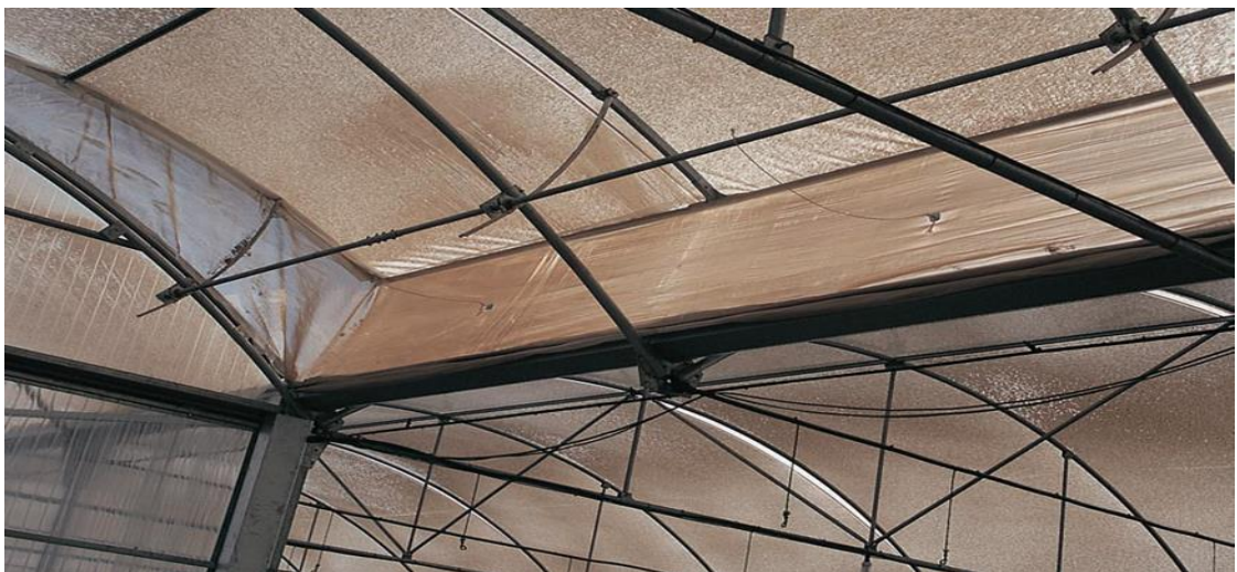
Figura N° I.3: Ventilación cenital en un invernadero de cubierta semicircular
