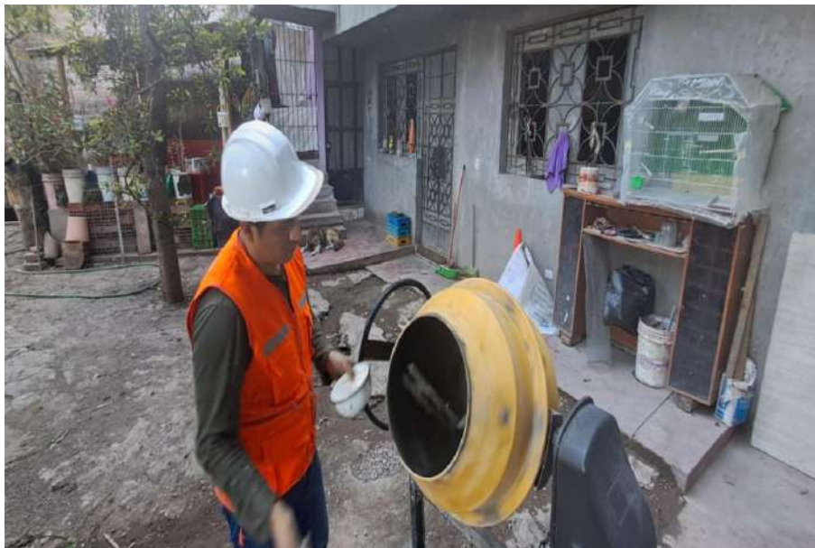
Figura 14: Proceso de mezclado con las fibras de polímeros
