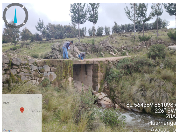
Imagen 3.5: Verificación del puente existente y trabajo de campo para recolección de datos.
