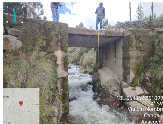
(b) Medida de los galibos del puente existente.
