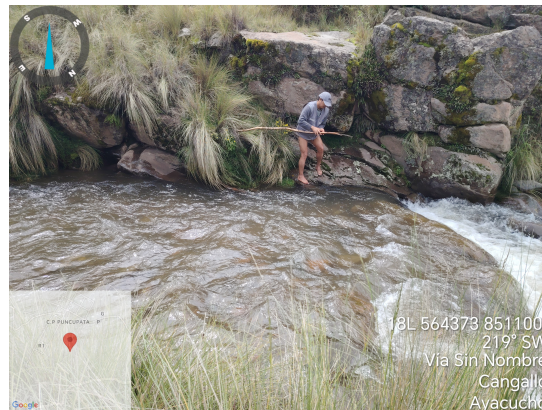
(a) Verificación de la socavación en el puente
