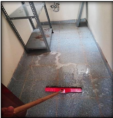
Fotografía 3.6: Limpieza y desinfección.
