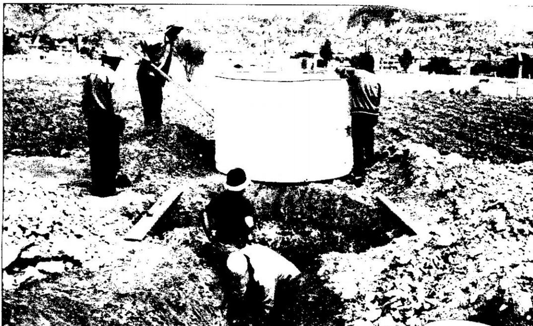
Anexo 17: Instalación del tanque lisimétrico en la parcela experimental. Canaán- INIA – Ayacucho 2760 msnm.
