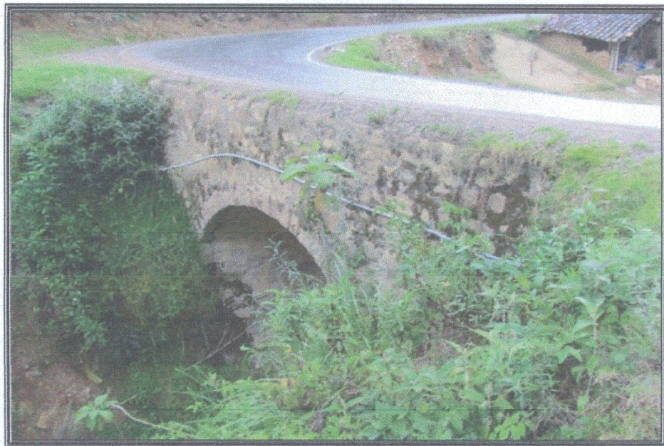
ALCANTARILLA ARCO PERFIL ALTO PROYECTADO (PROGRESIVA KM: 62+330)
