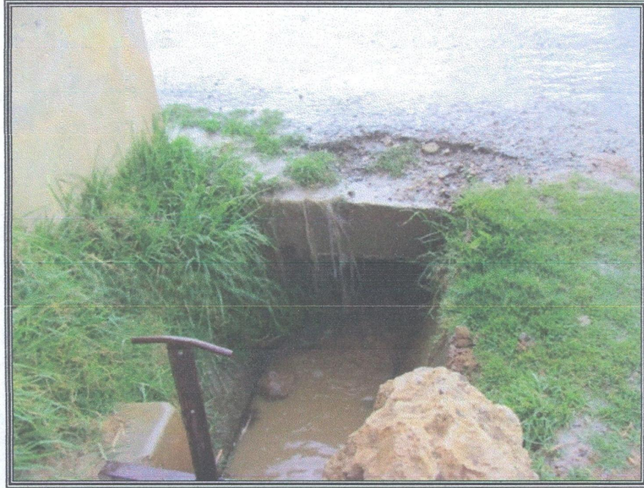
CRUCE DE CANAL DE RIEGO KM: 59+457 EN EL TRAMO DE CARRETERA SAN MARCOS
