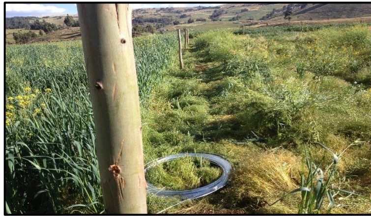
Figura 2.9. Instalación de cerco perimétrico
