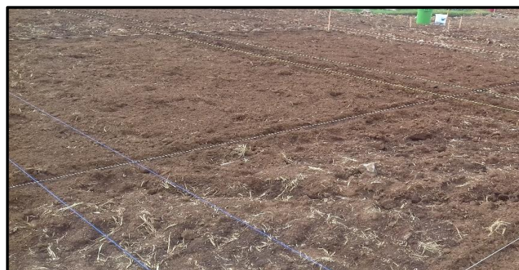
Figura 2.10. Trazo y replanteo del área de trabajo
