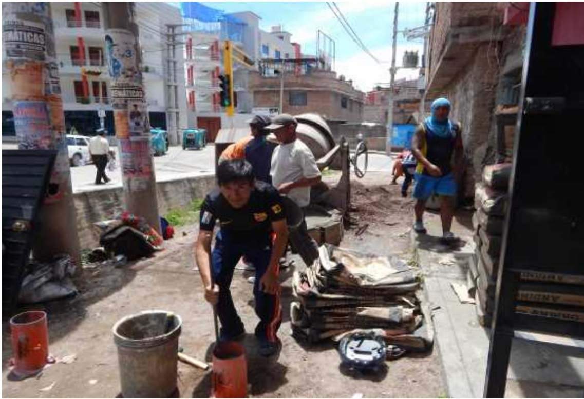
Foto 27: Toma de muestra de concreto en losa de vivienda N° 14
