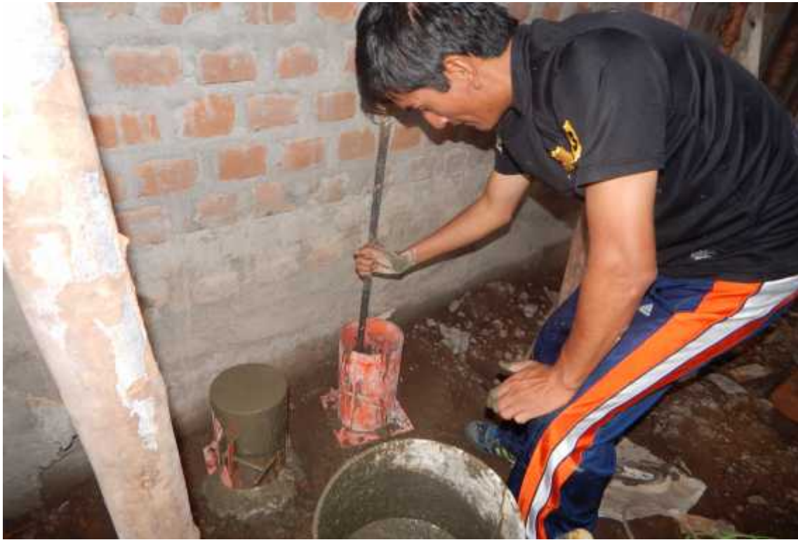
Foto 31: Toma de muestra de concreto en losa de vivienda N° 16
