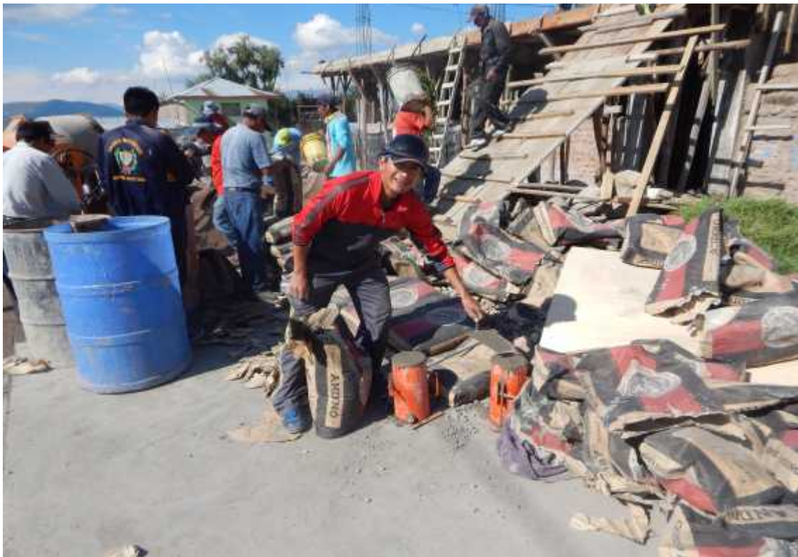
Foto 4: Toma de muestra de concreto en losa aligerada de vivienda N° 2
