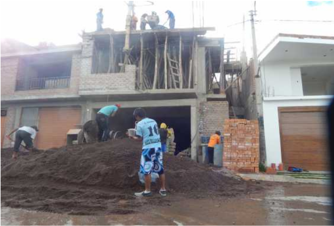
Foto 37: Vaciado con concreto en losa de vivienda N° 19; observando el transporte con uso de wincha y sin uso de compactación
