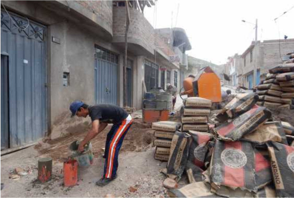
Foto 33: Toma de muestra de concreto en losa de vivienda N° 17
