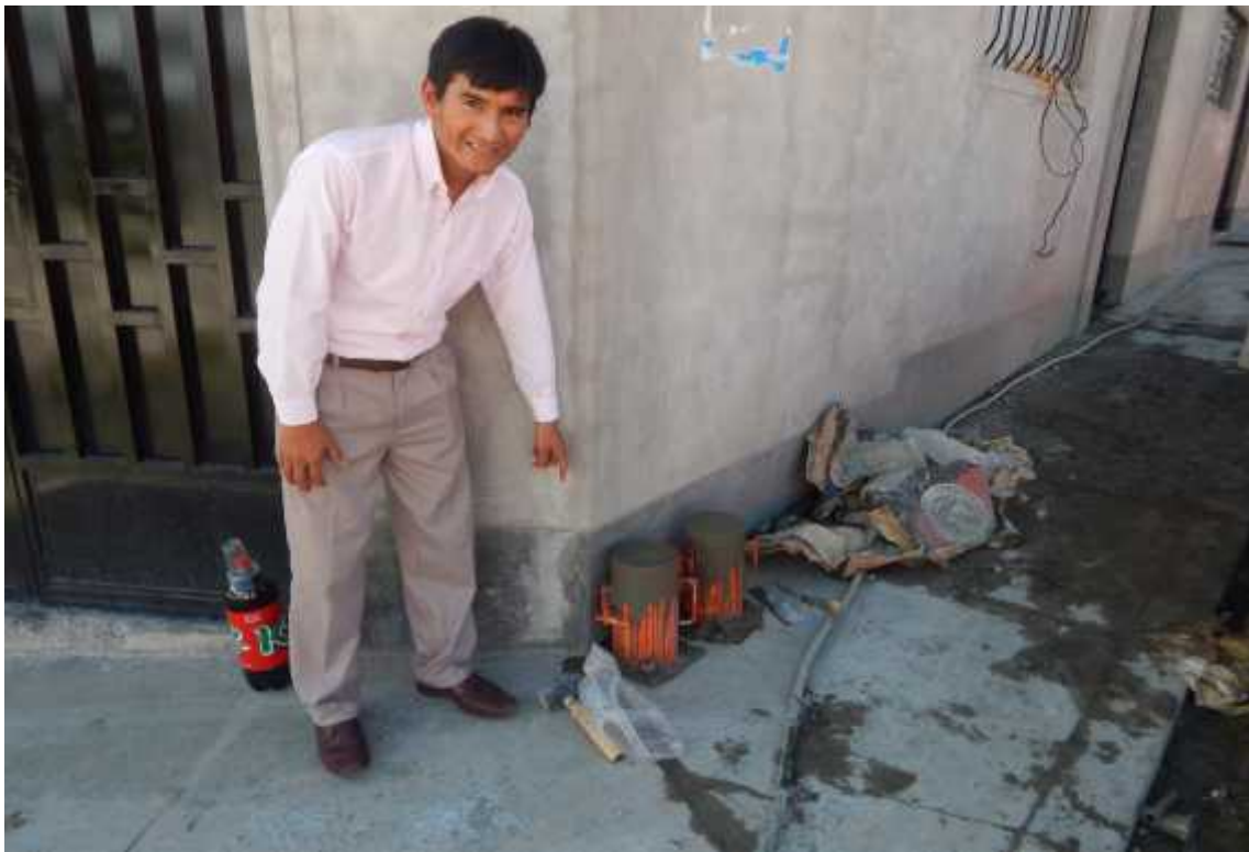
Foto 8: Toma de muestra de concreto de losa aligerada en vivienda N° 4
