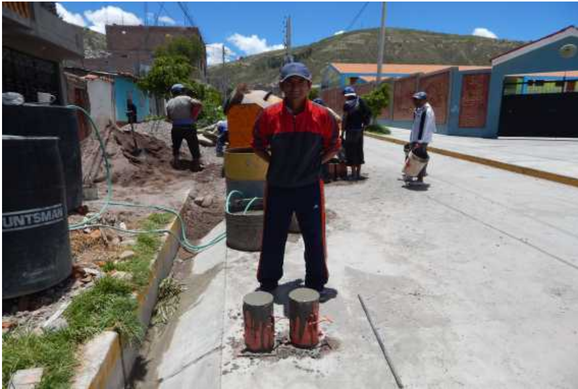
Foto 19: Toma de muestra de concreto en losa aligera de vivienda N° 10
