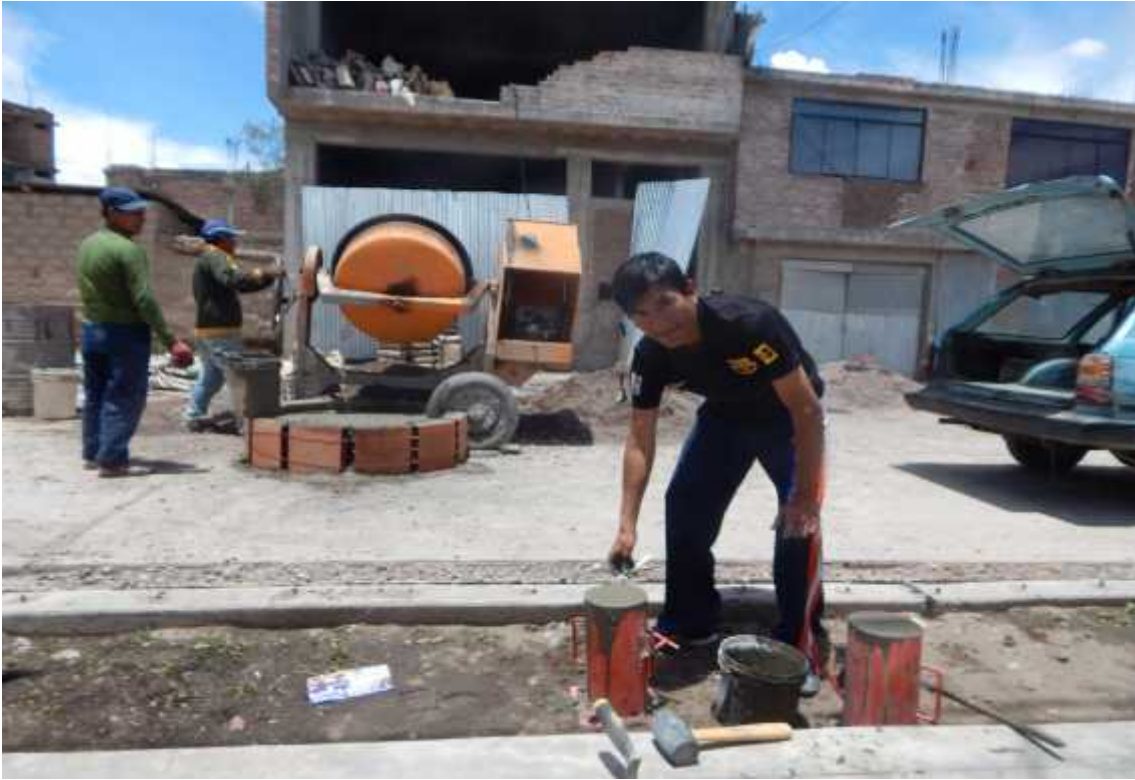
Foto 29: Toma de muestra de concreto en losa de vivienda N° 15
