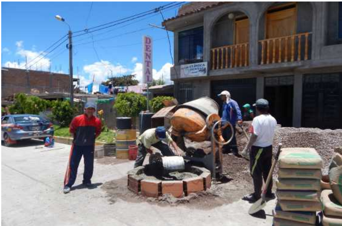
Foto 20: Dosificación de la mezcla con palas, transporte en baldes y sin compactación en vivienda N° 10
