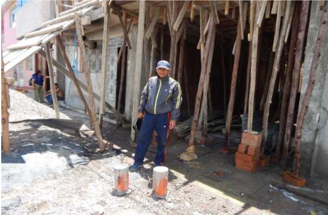
Foto 7: Desencofrado y recolección de muestras para su proceso de curado en laboratorio y en campo
