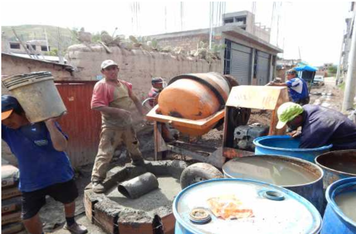
Foto 26: Dosificación de la mezcla con palas, transporte en baldes y sin compactación en vivienda N° 13
