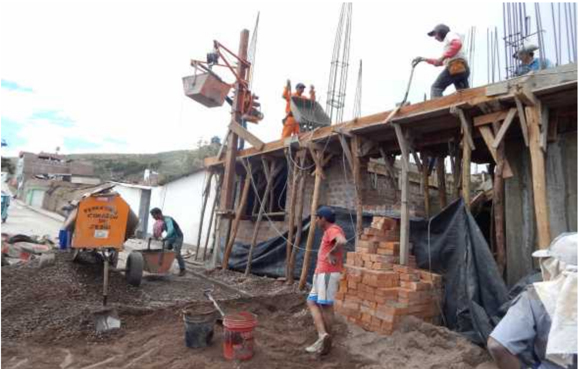
Foto 16: Dosificación de la mezcla con palas, transporte con wincha y sin compactación en vivienda N° 8
