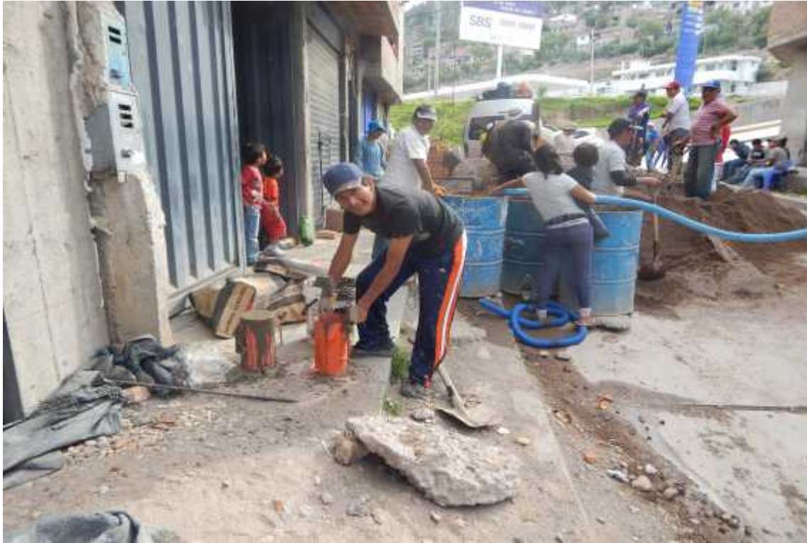
Foto 35: Toma de muestra de concreto en losa de vivienda N° 18
