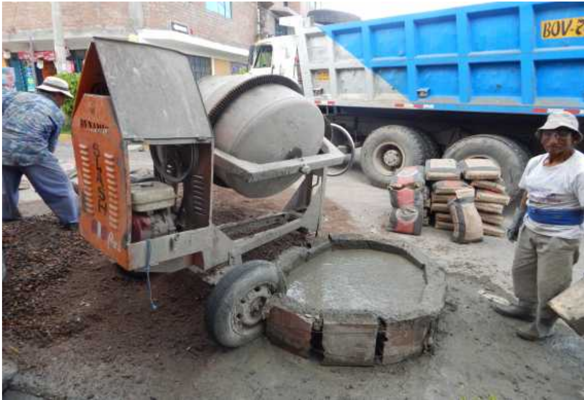
Foto 13: Dosificación de mezcla a palas y estado plástico del concreto y transporte en baldes en vivienda N° 7
