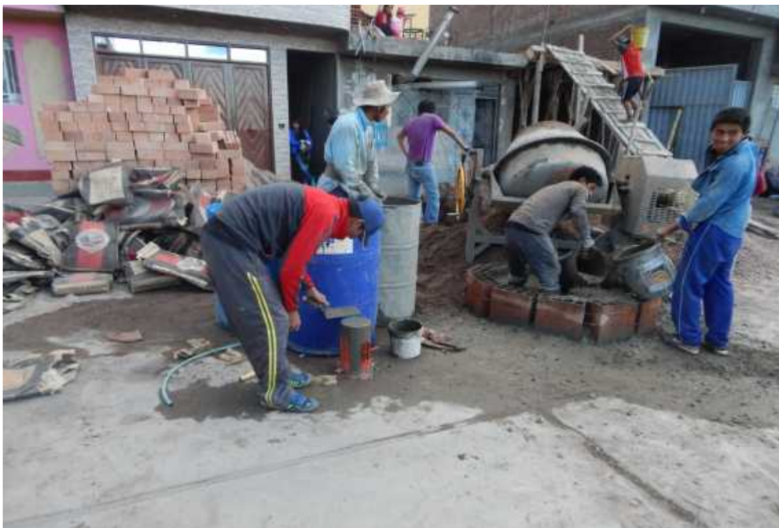
Foto 6: Toma de muestra de concreto en vivienda N° 3, dosificación de mezcla con palas y transporte en baldes
