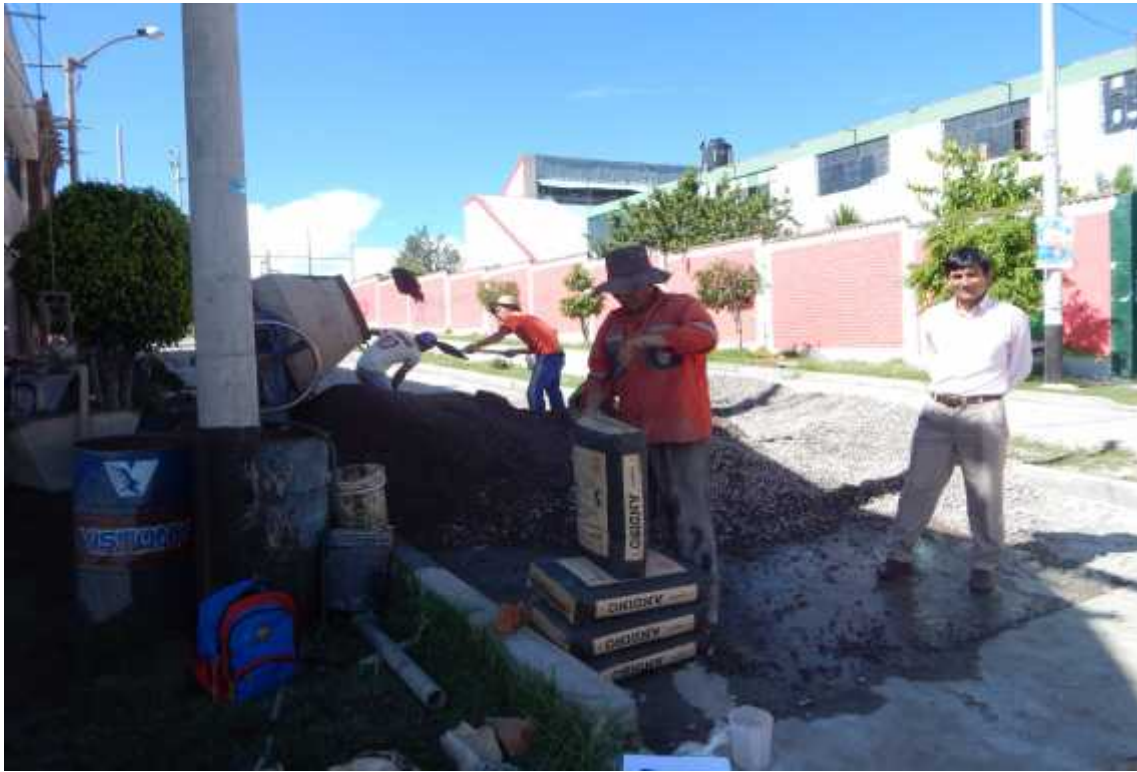
Foto 9: Dosificación de la mezcla con palas, transporte con wincha y sin uso de compactación
