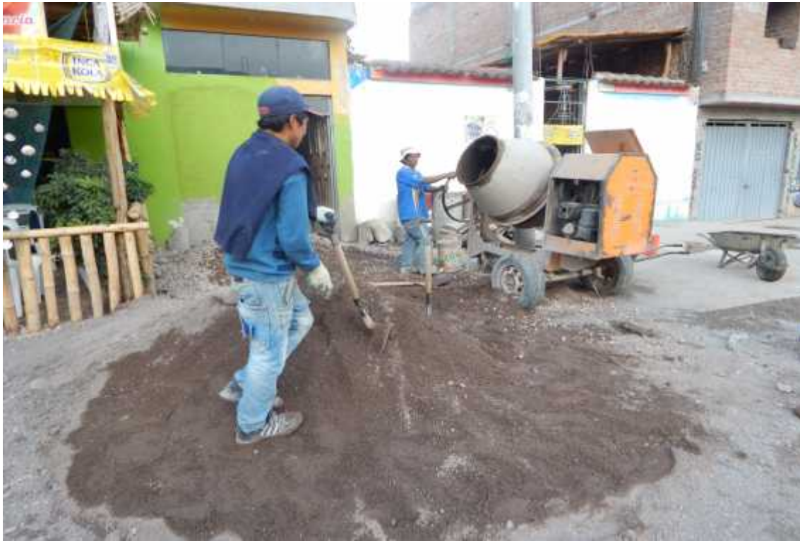
Foto 11: Dosificación de mezcla con palas y transporte en carretilla en vivienda N° 5
