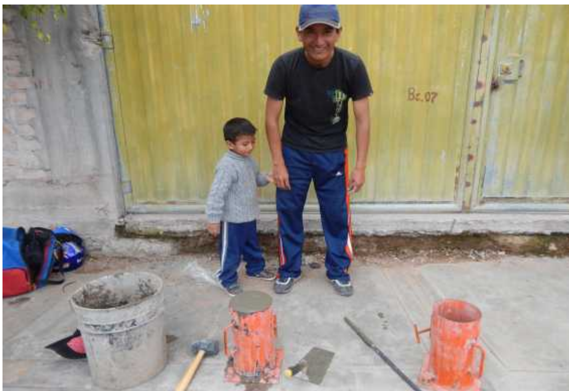
Foto 23; Toma de muestra de concreto en losa de vivienda N° 12
