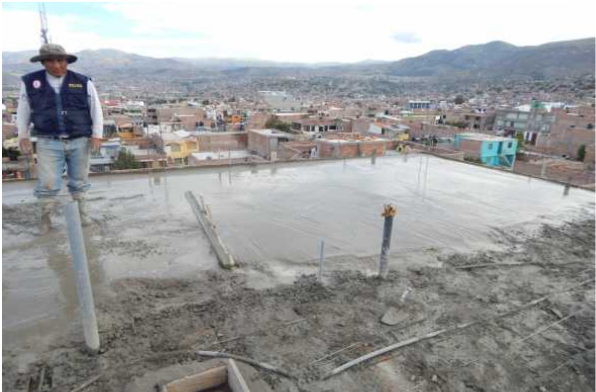
Foto 14: Vaceado con concreto en losa de vivienda N° 7; observando mucha exudación
