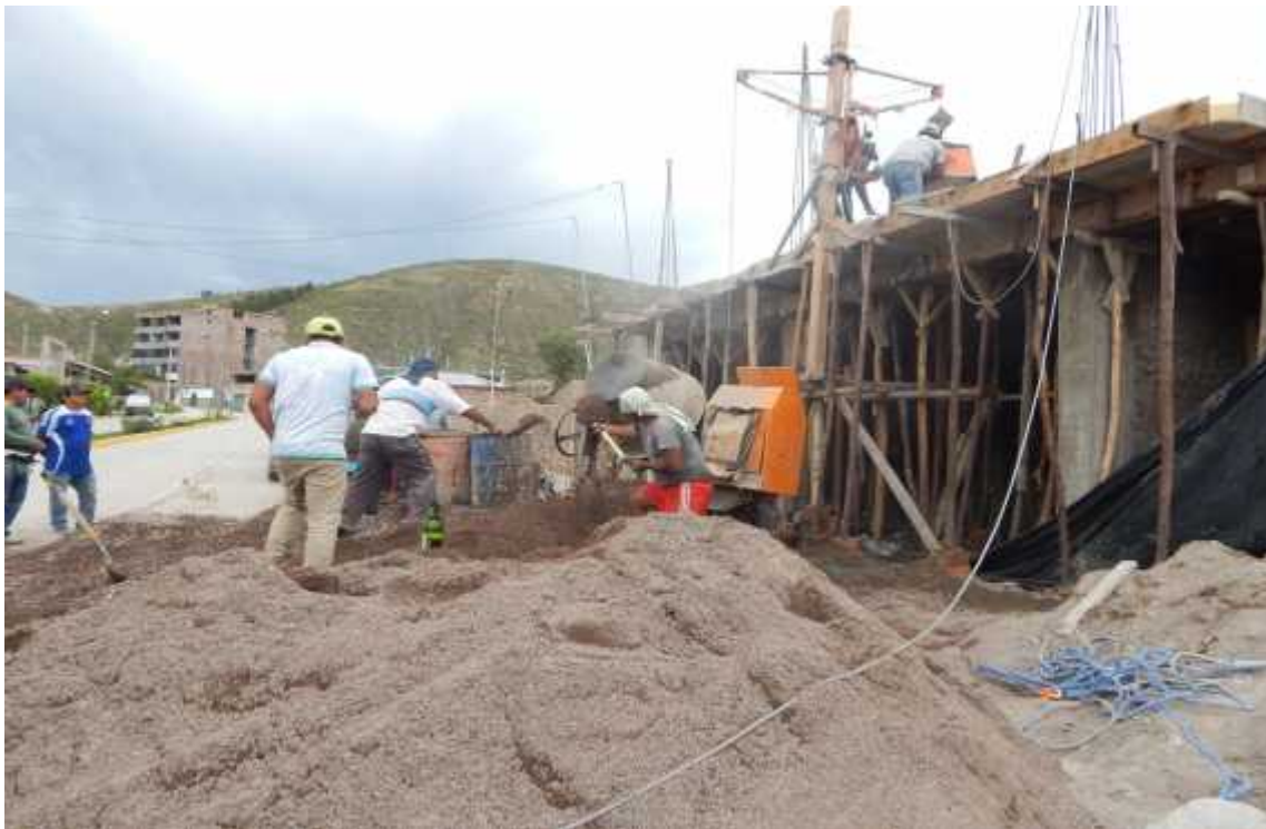
Foto 32: Dosificación de mezcla con palas, transporte con wincha y sin uso de compactación en vivienda N° 16
