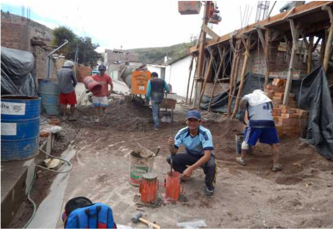
Foto 15: Toma de muestra de concreto en losas de vivienda N° 8
