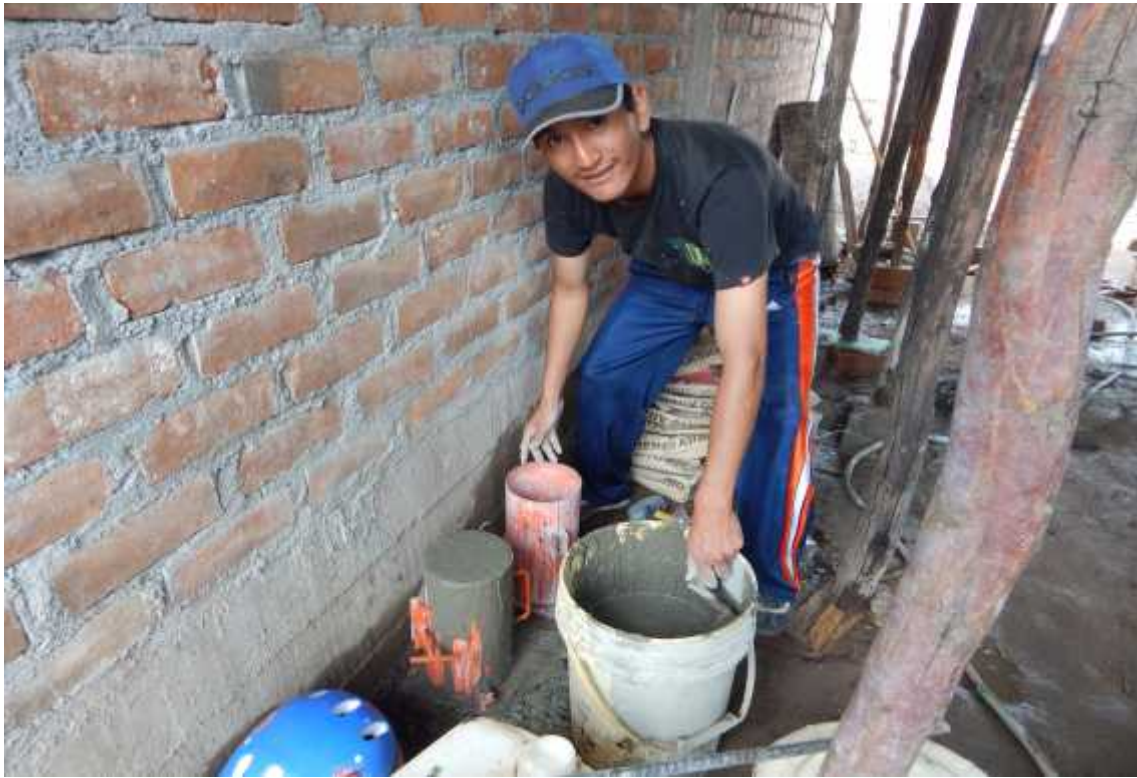
Foto 25: Toma de muestra de concreto en losa de vivienda N° 13
