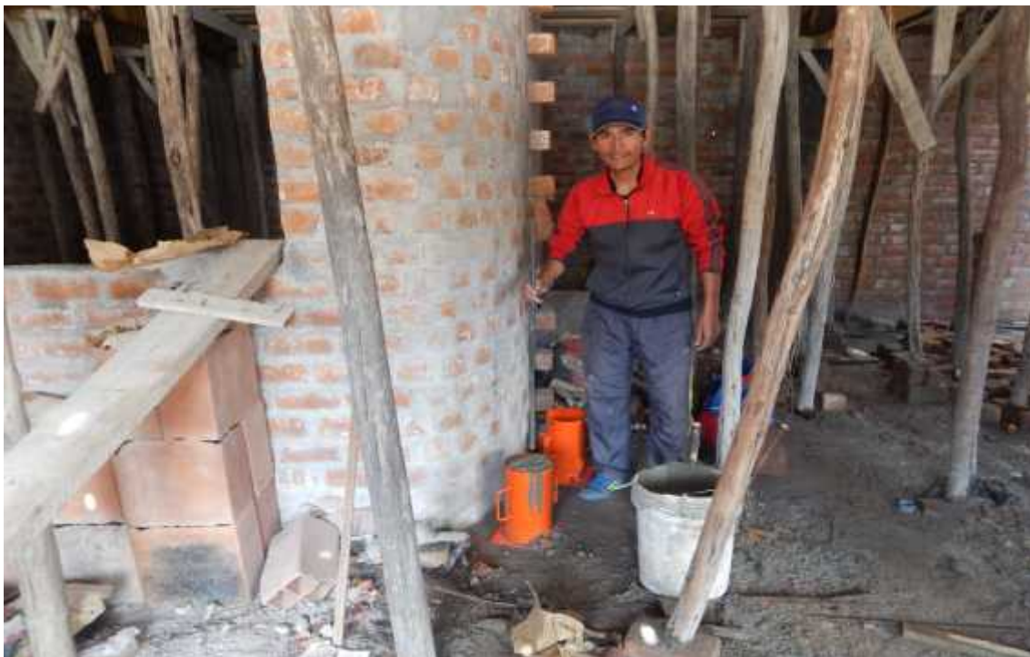
Foto 2: Toma de muestra de concreto de losas aligerada de vivienda N° 1
