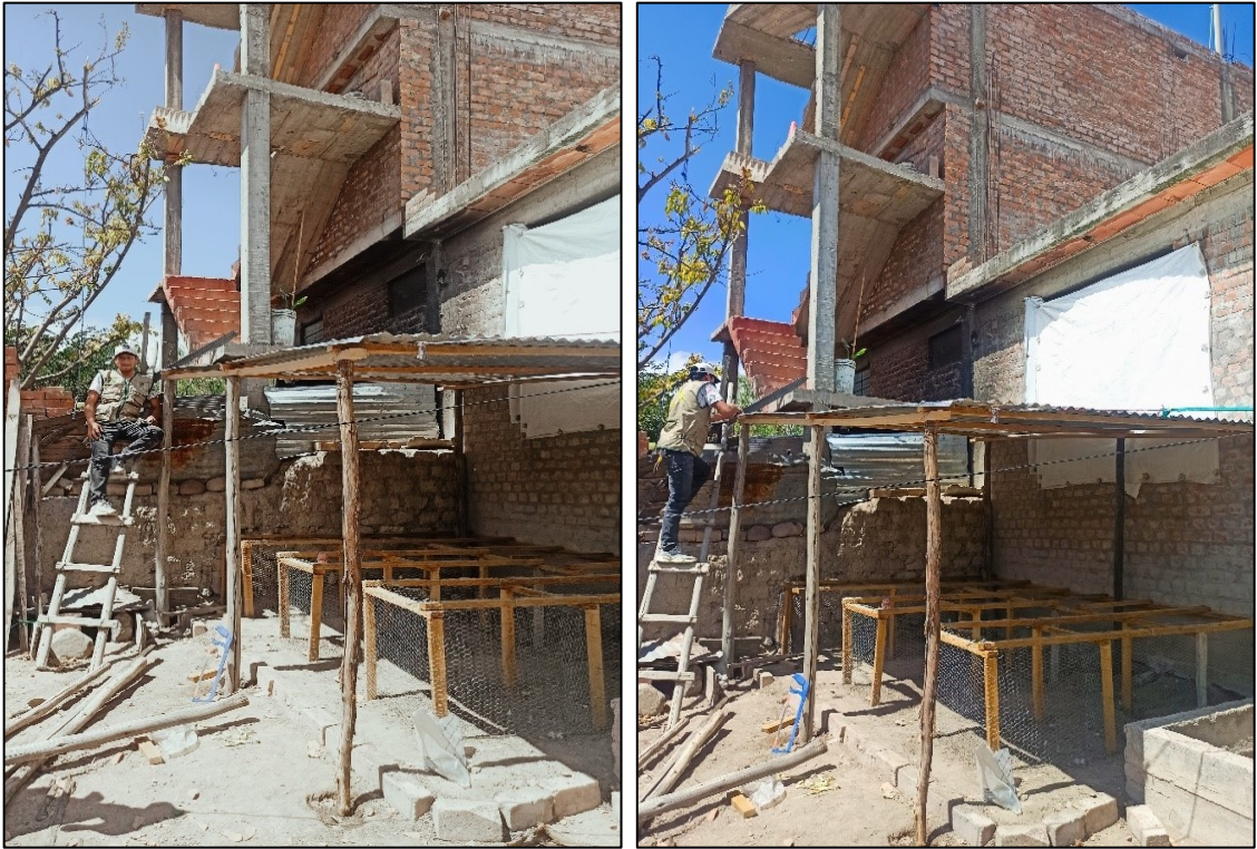
Fotografía 1. Construcción del galpón.
