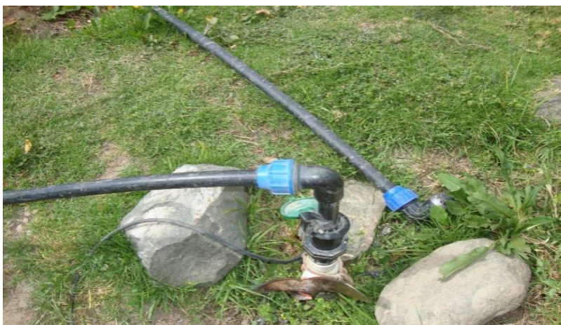
Figura 2.17. Antes (Hidrante de \frac{3}{4} ").
