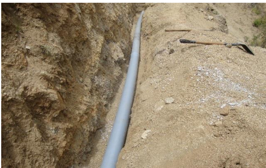
Figura 2.14. Actual (canal entubado con 160mm)
