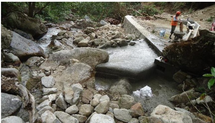
Figura 2.10. Actual (captación tipo ventana)
