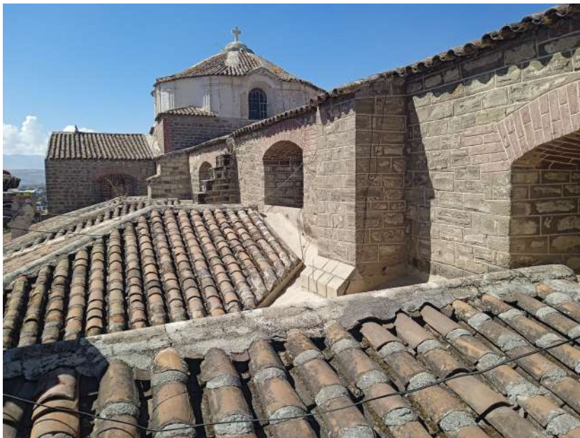
Vista del techo de la nave lateral derecha
