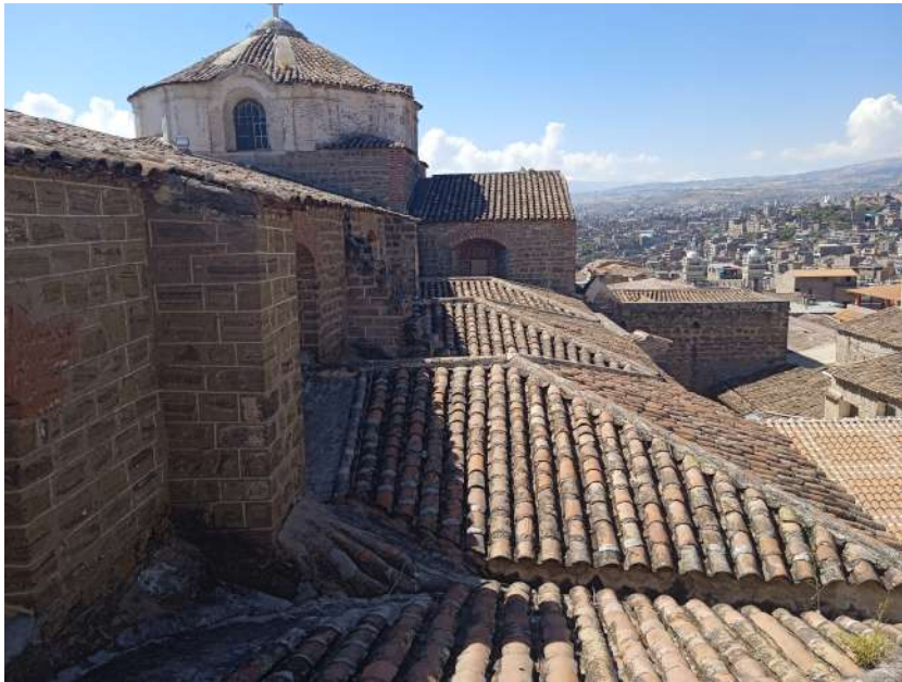
Vista del techo de la nave lateral izquierda
