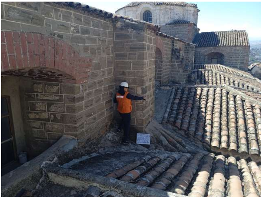
Corroboración de medidas
