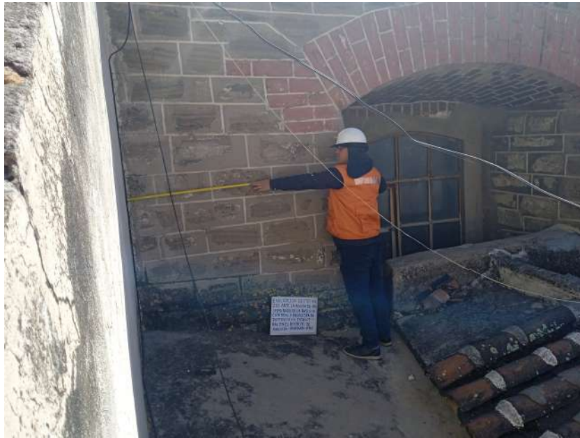
Corroboración de medidas
