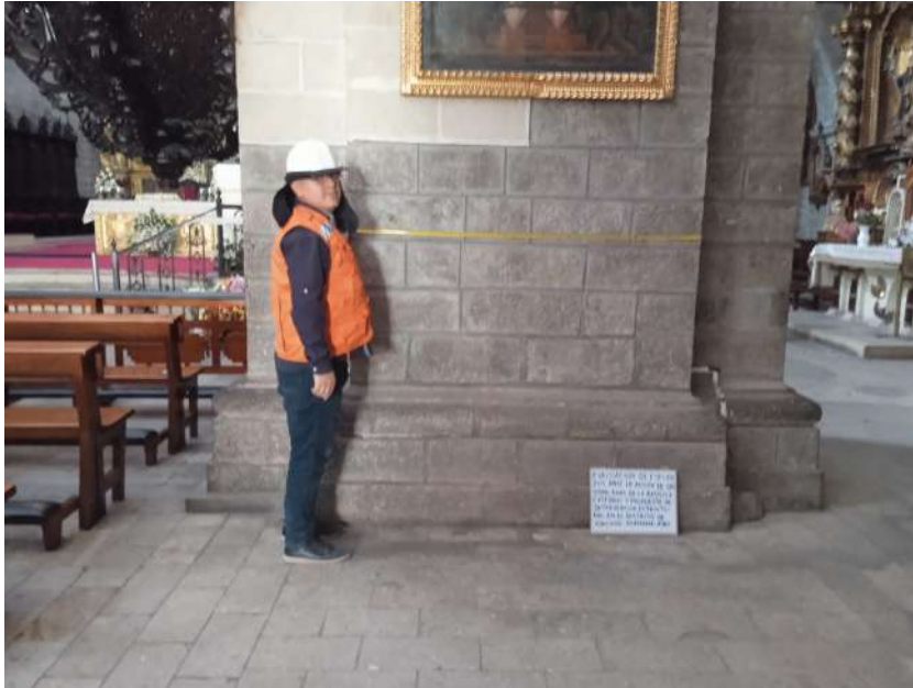
Corroboración de medidas en columnas
