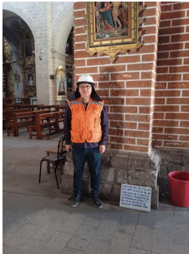
Columna con revestimiento y pintura
