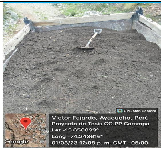
Fotografía 02: actividad de traslado de tierra turba en le volquete de 6 m 3
