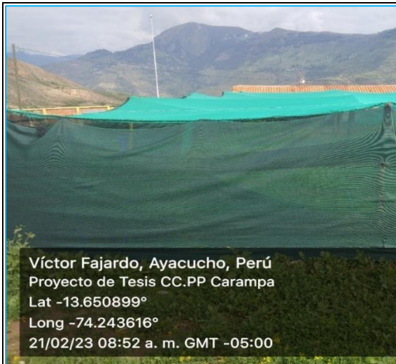
Fotografía 07: actividad de construcción de vivero de aérea 72 m 2
