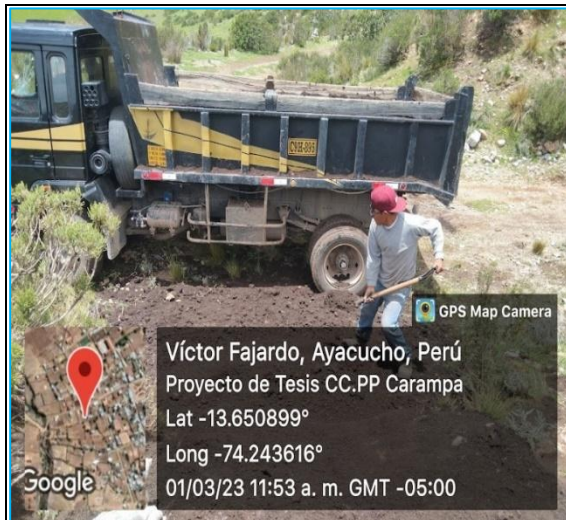
Fotografía 01: actividad de carguío de tierra turba en el volquete de 6m 3
