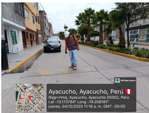
(a) Reductor con pintura desgastada
