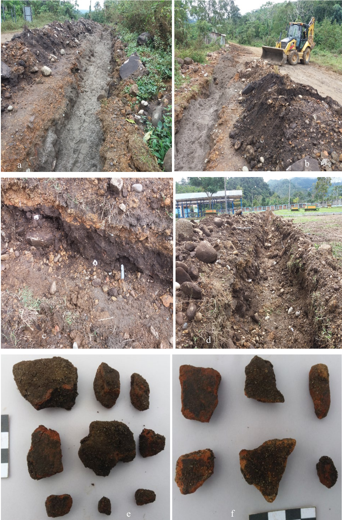
Figura 9. Excavación y tendido de tuberías en la trocha carrozable Pichari-Sankiroshi (a, b); corte de canal (c), zanja de sistema de alcantarillado (d) y fragmentos de cerámica (e, f).
