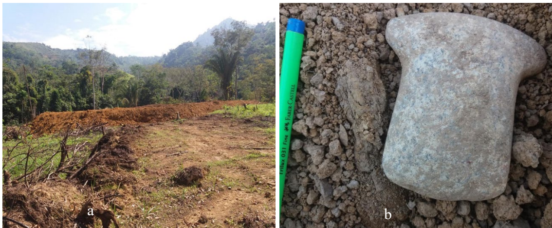
Figura 23. Construcción de reservorio (a), hacha de piedra del primer reservorio (b).
