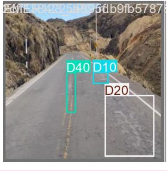
Figura 79 Predicción del modelo YOLO V12, para el reconocimiento del tipo de falla
