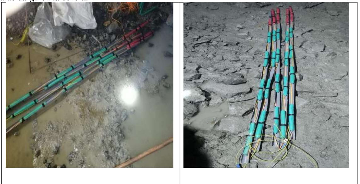
Figura 47. Columna de carga en la corona
