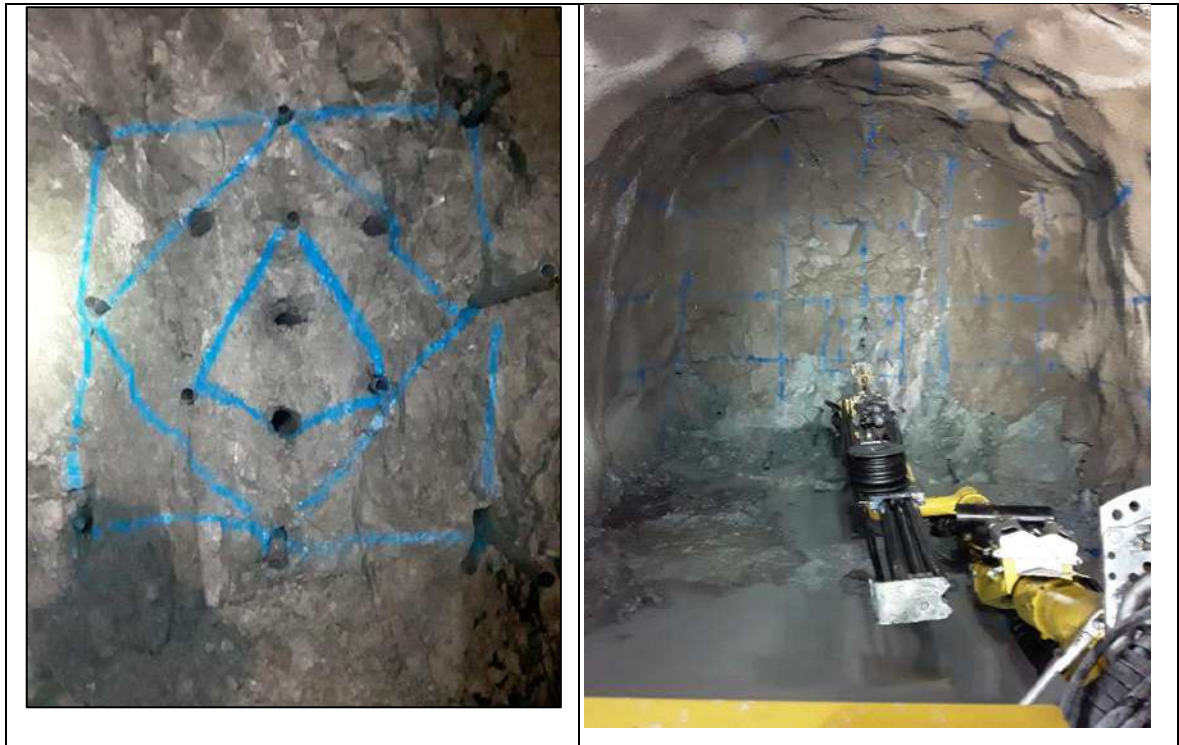
Figura 21. Malla de perforación con arranque hexagonal
