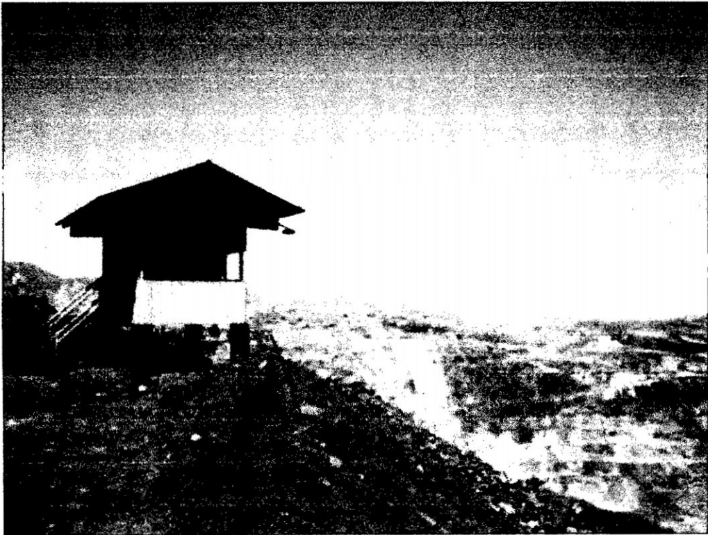
Figura N° 39: Cabina de Dispatch
