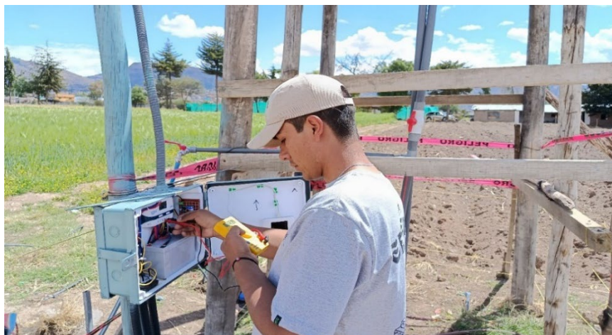
Verificación eléctrica del sistema de riego
