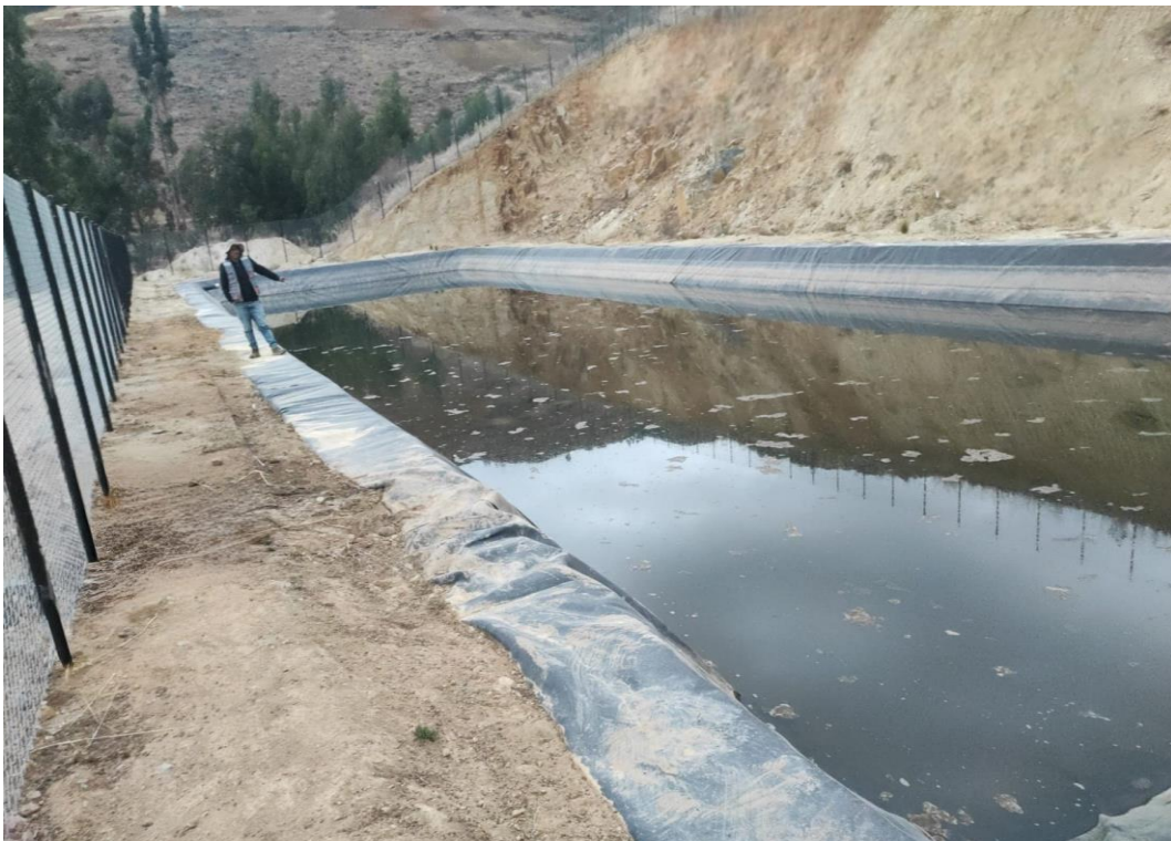
Fotografía 14: Embalse del reservorio para el sistema de riego
