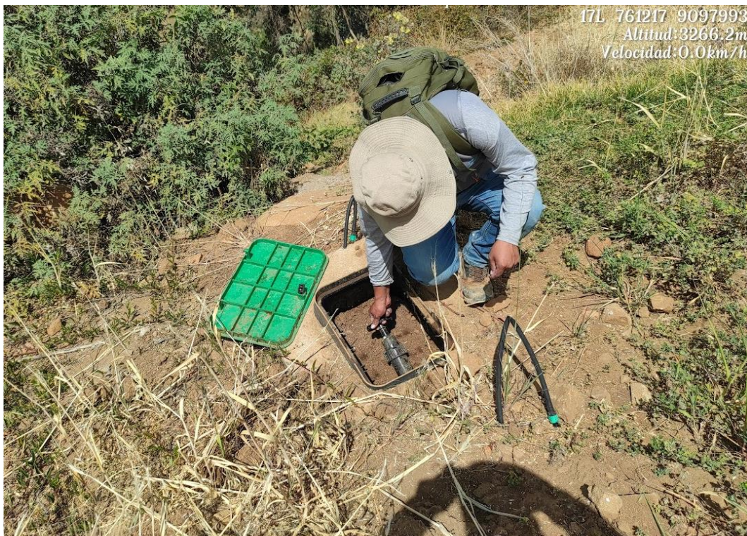
Fotografía 12: Regulando la presión en la parcela demostrativa 01, por tener una fuerte pendiente para toma de muestra de presión y caudal en la parte baja
