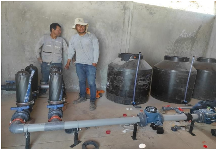
Cabezal de riego tipo de filtrado (filtro de anillas)
