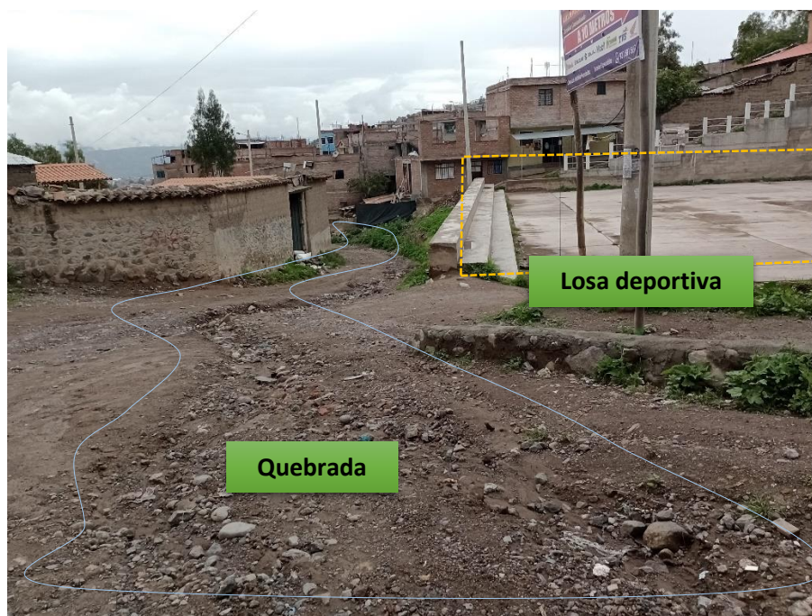
Figura 3.5. Losa deportiva ubicada en una curva de la quebrada.
