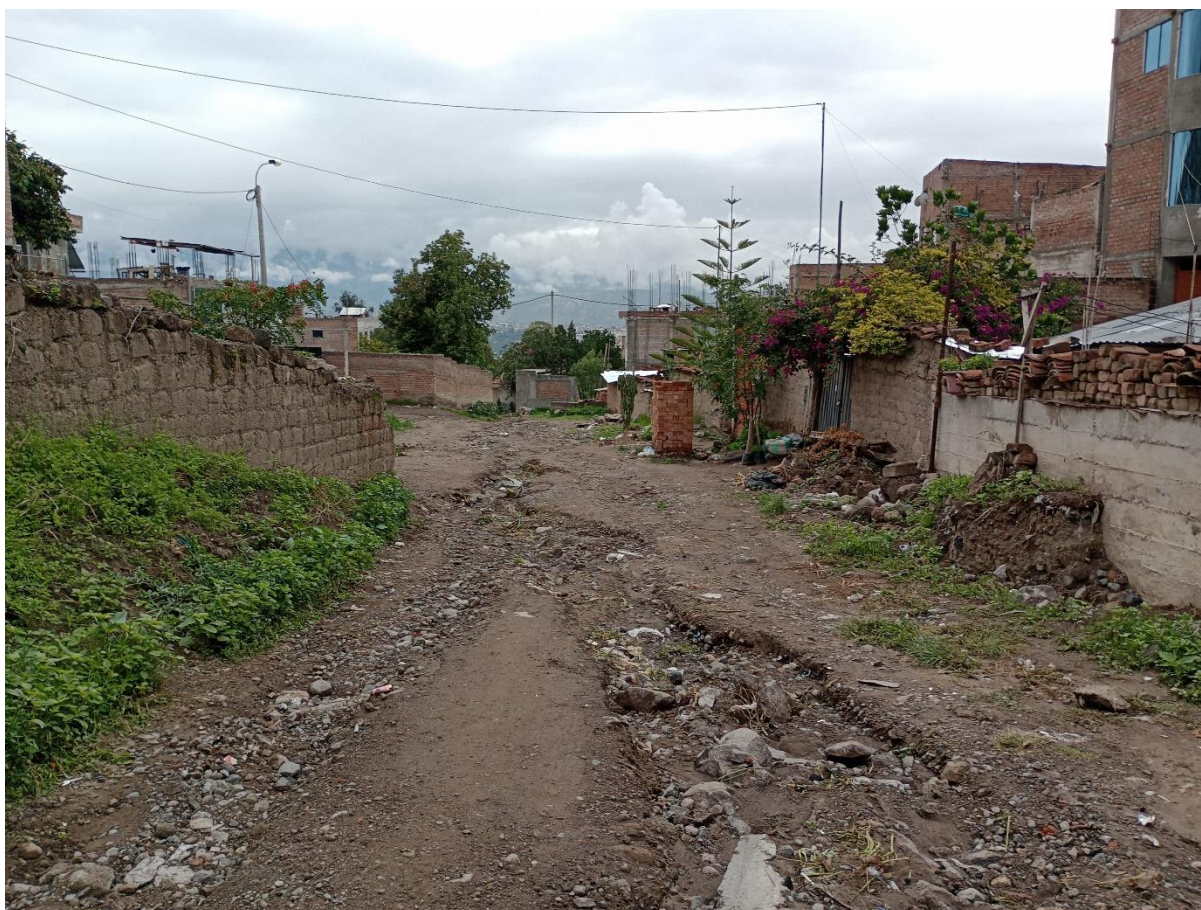
Figura 2.6. Fotografía tomada al recorrido de la quebrada Santa Cecilia, mostrando la cercanía de las viviendas
