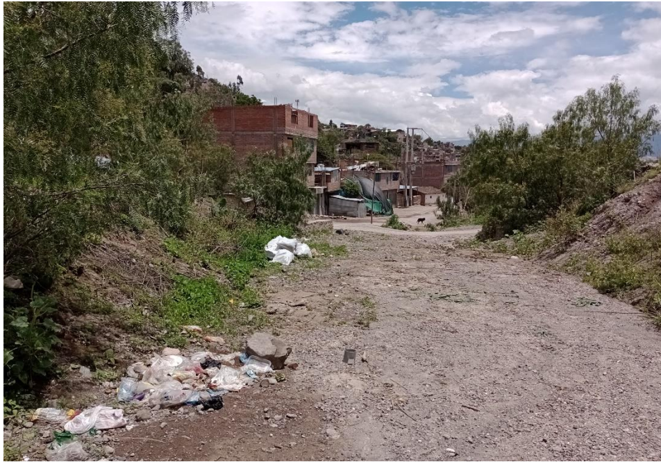
Figura D.6. Se muestra montículos de basura sobre la quebrada, lo que aumentaría el nivel del impacto del peligro por flujo de detrito.
