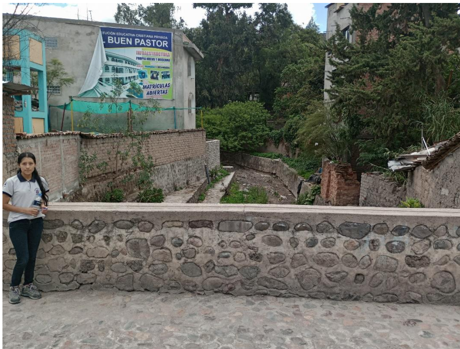
Figura D.13. La quebrada estaría desembocando por el paso del rio Sotoq Chaca por el puente colonial del Jr. Grau.
