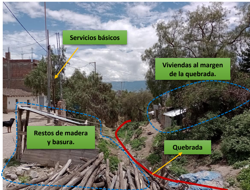
Figura 3.4. Viviendas y materiales de construcción sobre la quebrada
