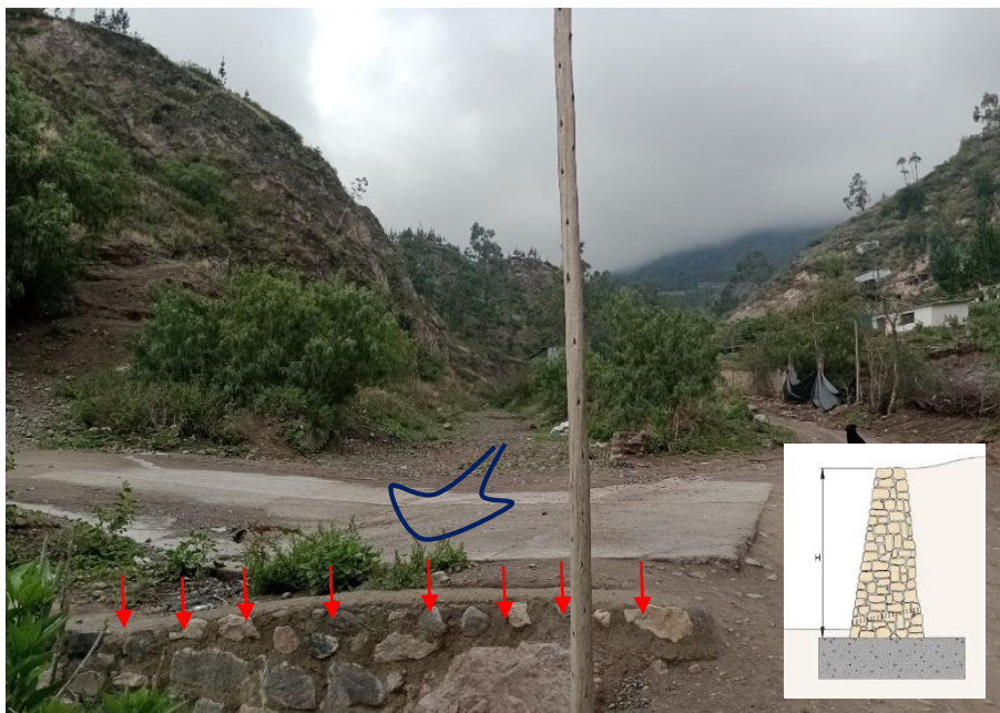
Figura 3.10. Fotografía del muro de contención de mampostería con un badén para el paso de vehículos
