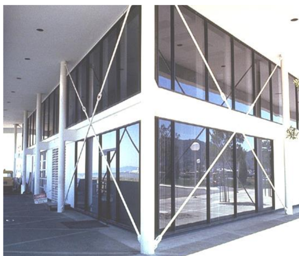
Figura 2.10: Pódium arriostrado con tensores en X
