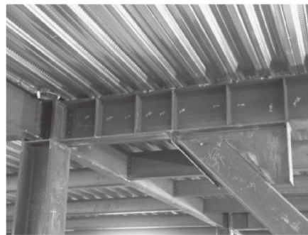
(b) EBF con enlaces exteriores
