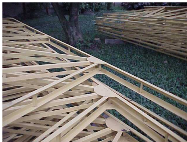
Figura 2.22: Armaduras en ángulos enfrentados
