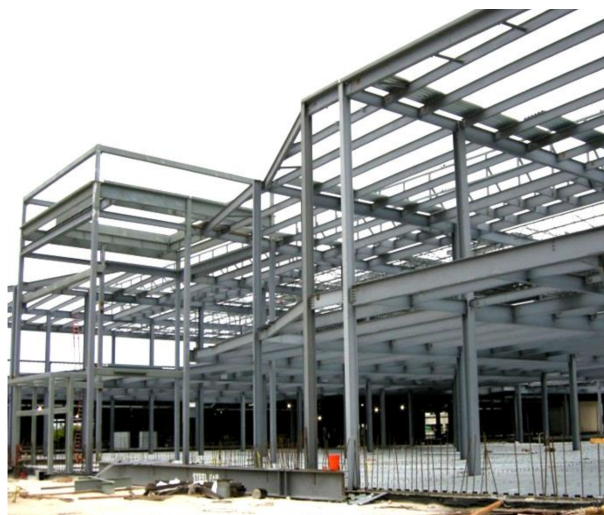
Figura 2.2: Vista general de una estructura de pórticos no arriostrados para un edificio comercial
