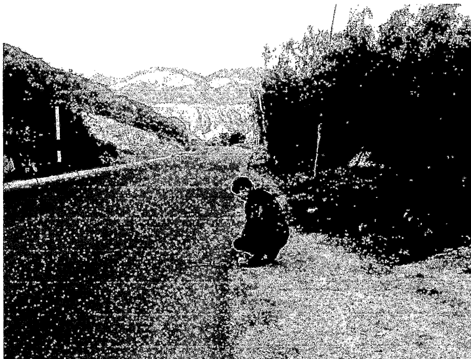
Figura 6.5: Medición de berma de la vía PE 3S (Ayacucho - Cuzco) - Fuente. Elaboración Propia
