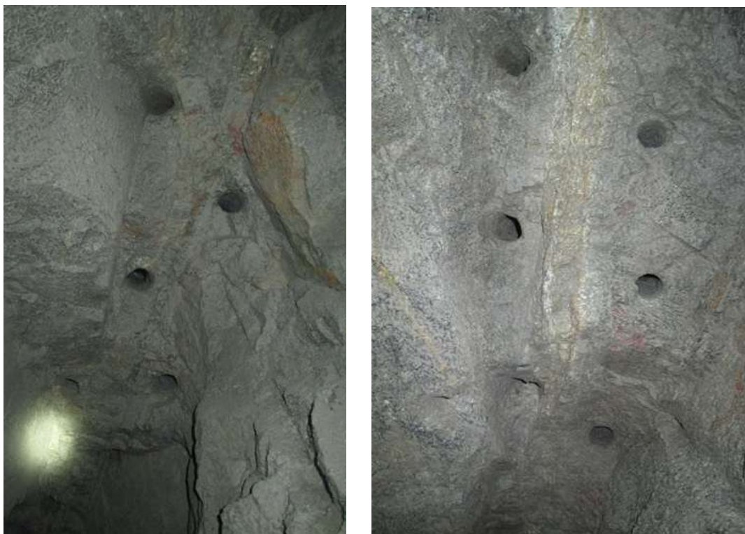
Figura 23: Malla de perforación en Zig – Zag – Tj168 – Chinchilico. Fuente: autor de tesis
