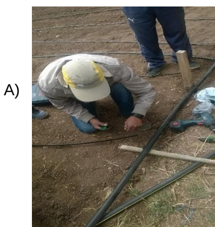
A) conexión de mangueras para cada surco y B) completo instalado de mangueras de 16 MM x 500 m.
