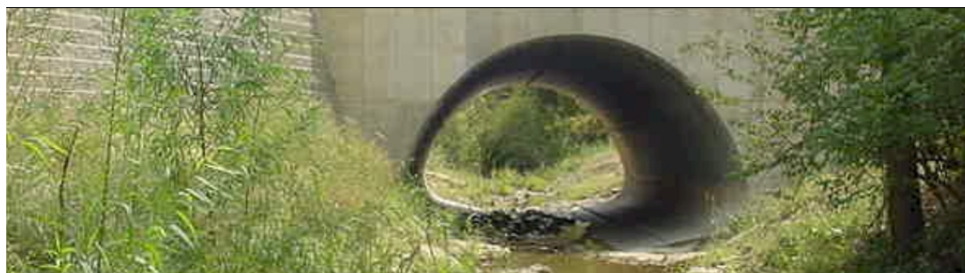
Figura 2.19: Alcantarillas de forma abovedado, L_{max}=7.62 m, F_{max}=4.24 m.
