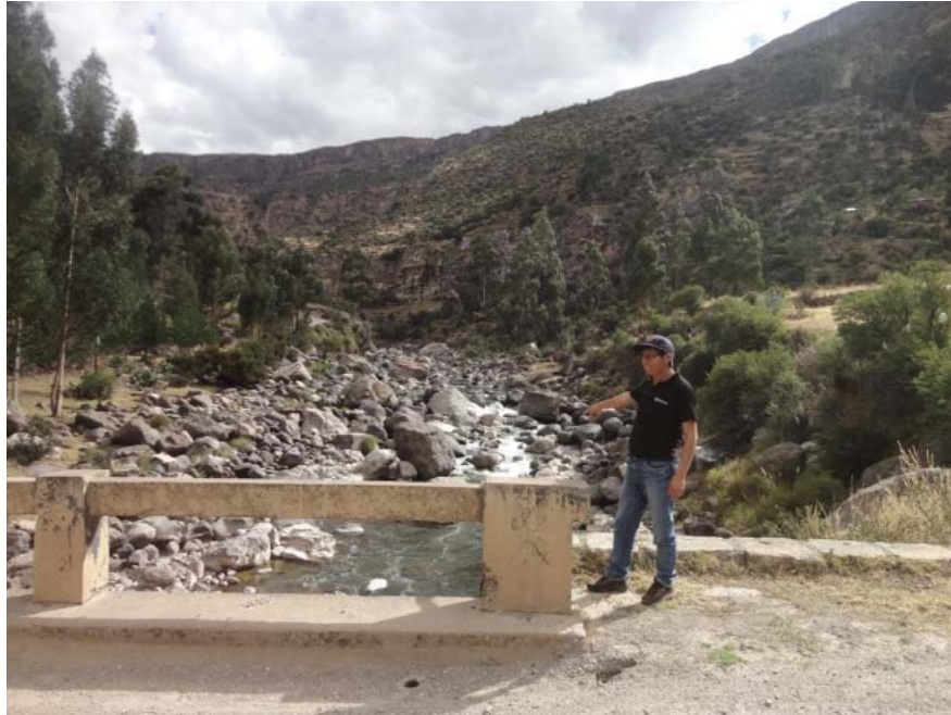
Vista 01: Aguas arriba del puente Marita, en el río Caracha.
