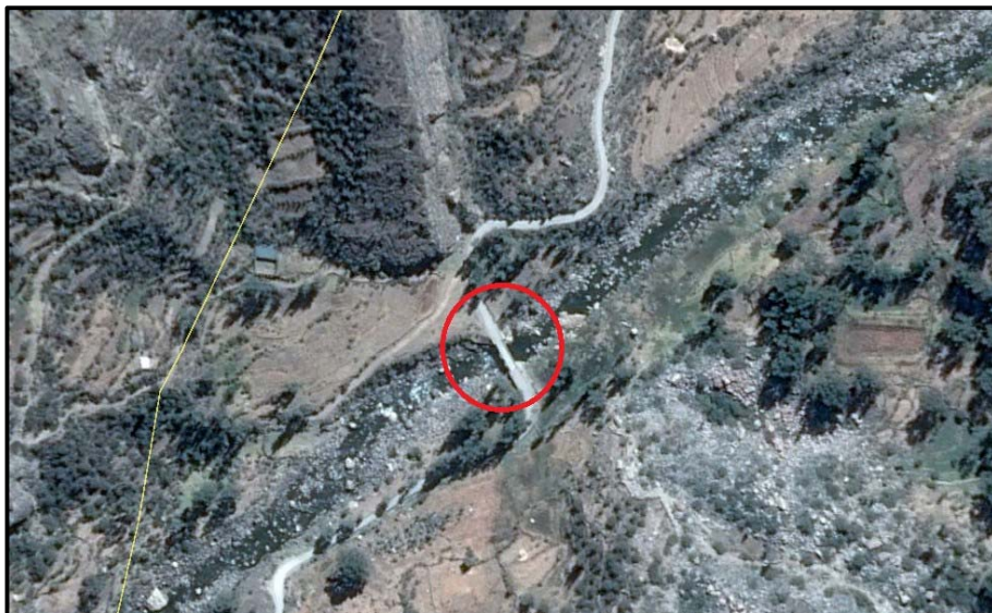
Figura 1: Ubicación del Puente Marita
