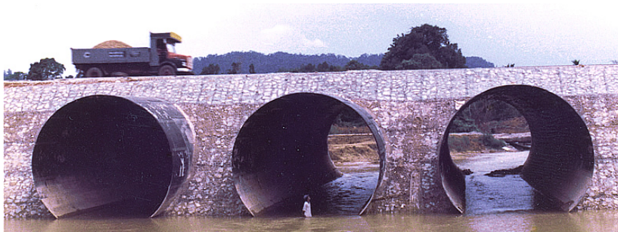
Figura 2.17: Alcantarillas de forma circular, D_{max}=15.80 m.
