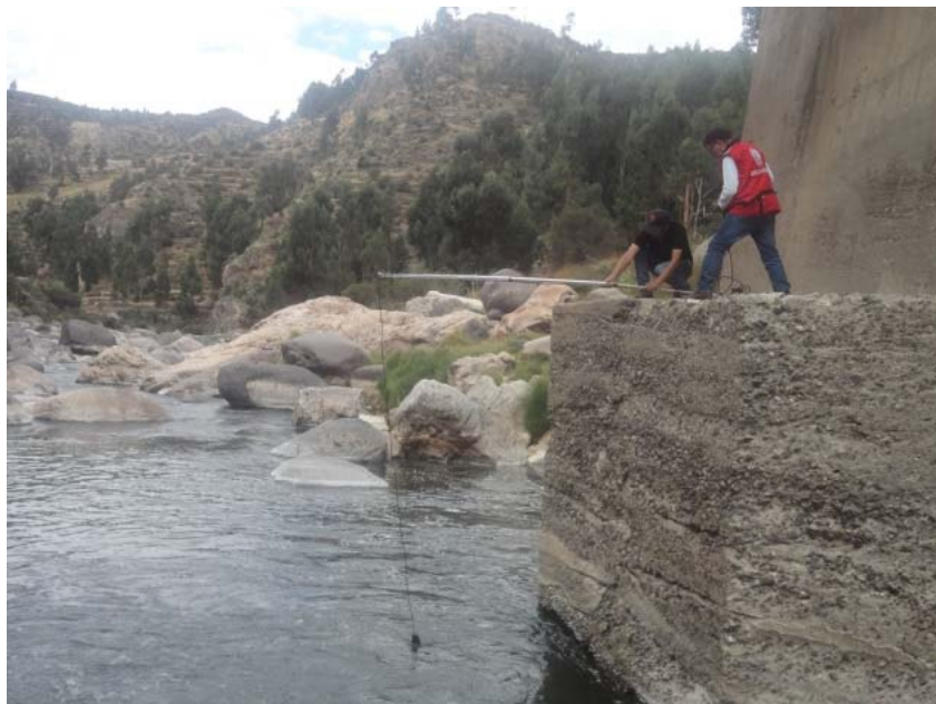
Vista 06: Midiendo profundidad de socavación con ecosonda en estribos derecho del puente Marita, en el río Caracha.
