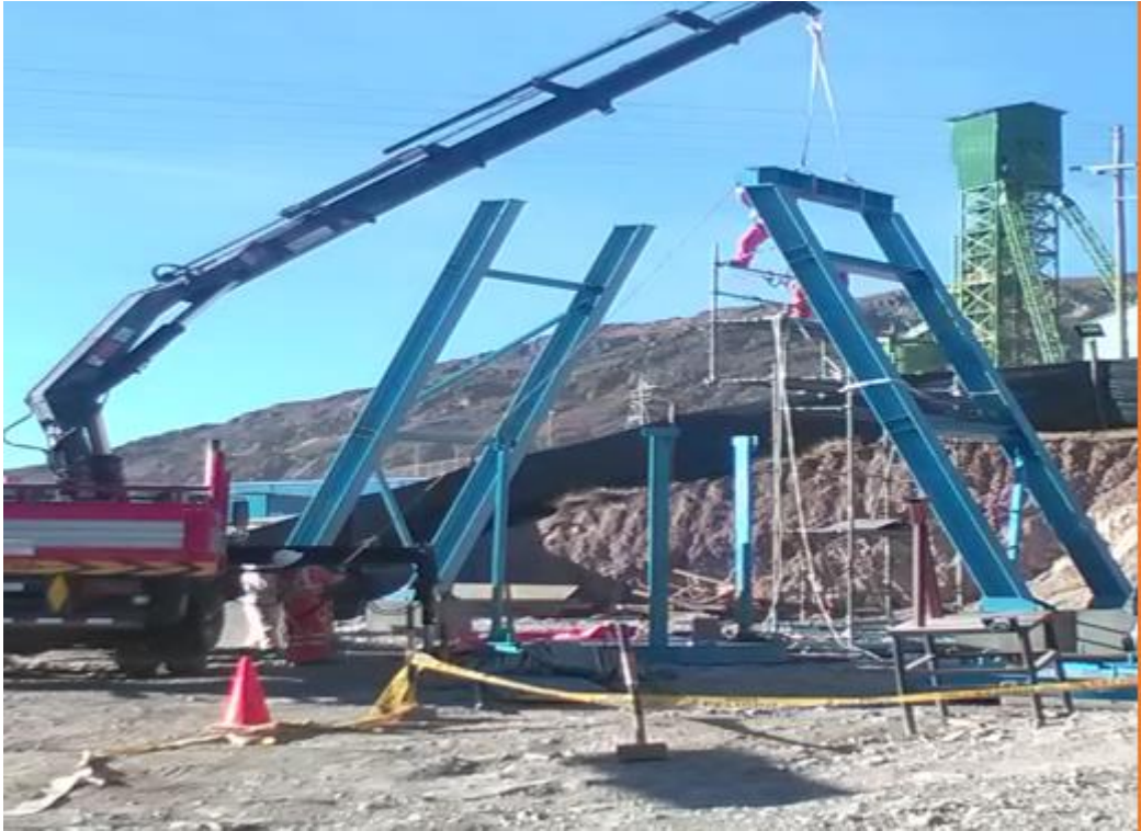
Figura 32 Proceso del montaje del castillo
