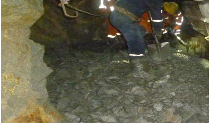
Figura 44. Limpieza manual de pique inclinado 719
