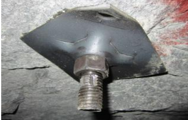
Figura 11. Perno Helicoidal
