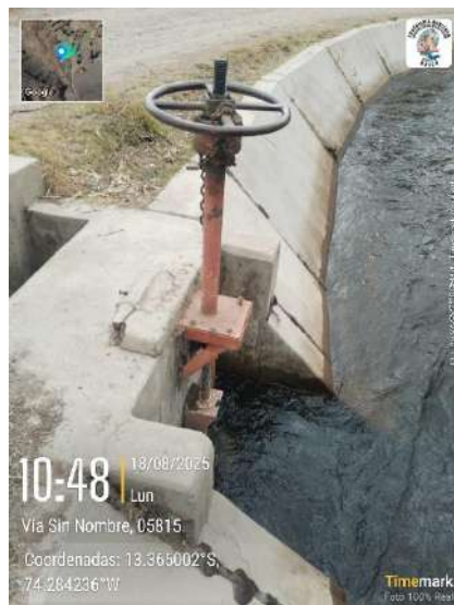
Figura 35. Toma lateral en canal principal en Manzanayocc.
