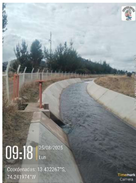
Figura 48. Toma lateral en el canal principal de proyecto CACHI.
