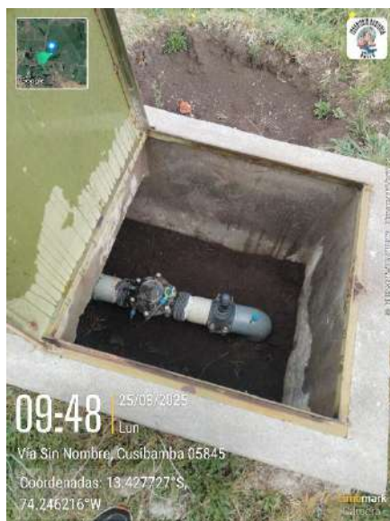
Figura 52. Válvula parcelaria en Cusibamba
