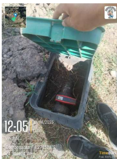
Figura 41. Válvula parcelaria directa en Manzanayocc.
