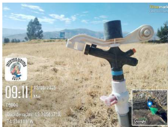
Figura 32. Válvula de apertura y cierre junto al aspersor en Casaorcco.
