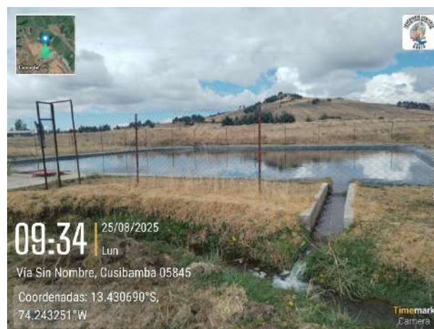
Figura 47. Reservorio de Cusibamba.
