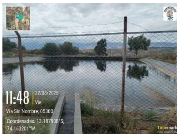
Figura 42. Reservorio – 01 de Santa Bárbara.
