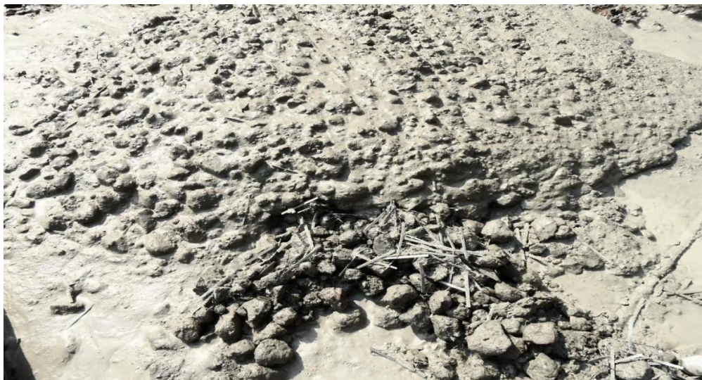
Figura N° 18. Desperdicio de concreto al momento del traslado
