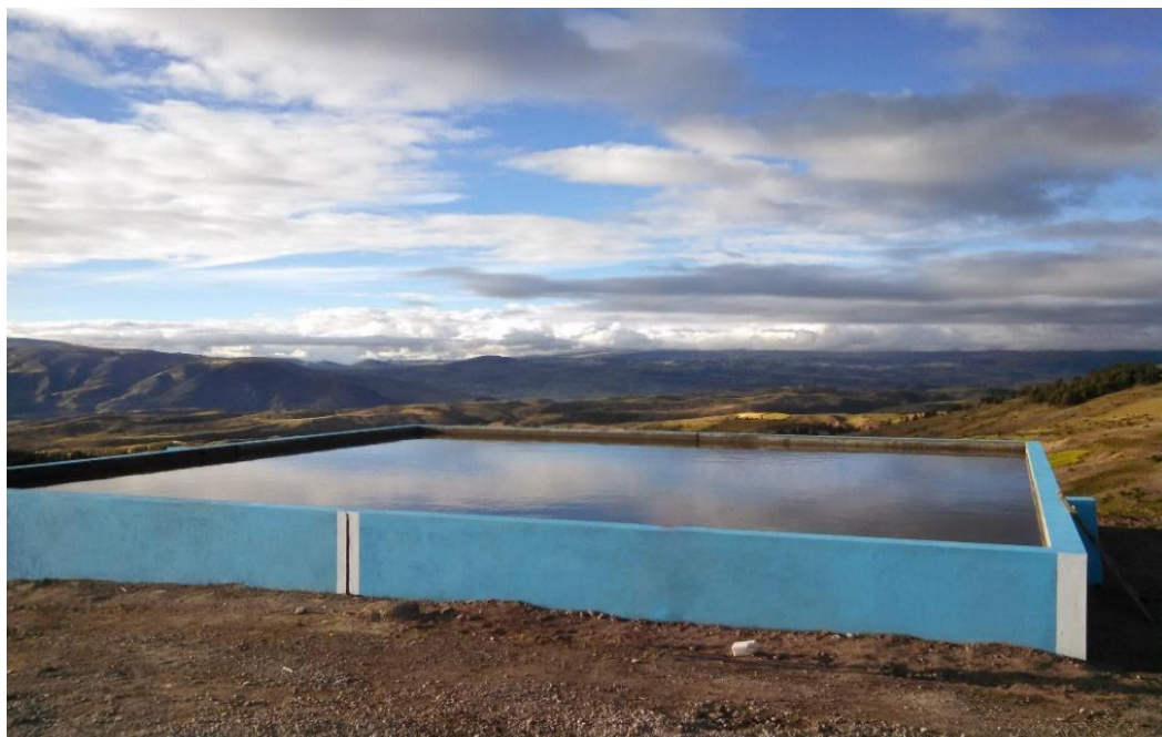
Figura Nº 1. Reservorio nocturno de concreto armado para riego
