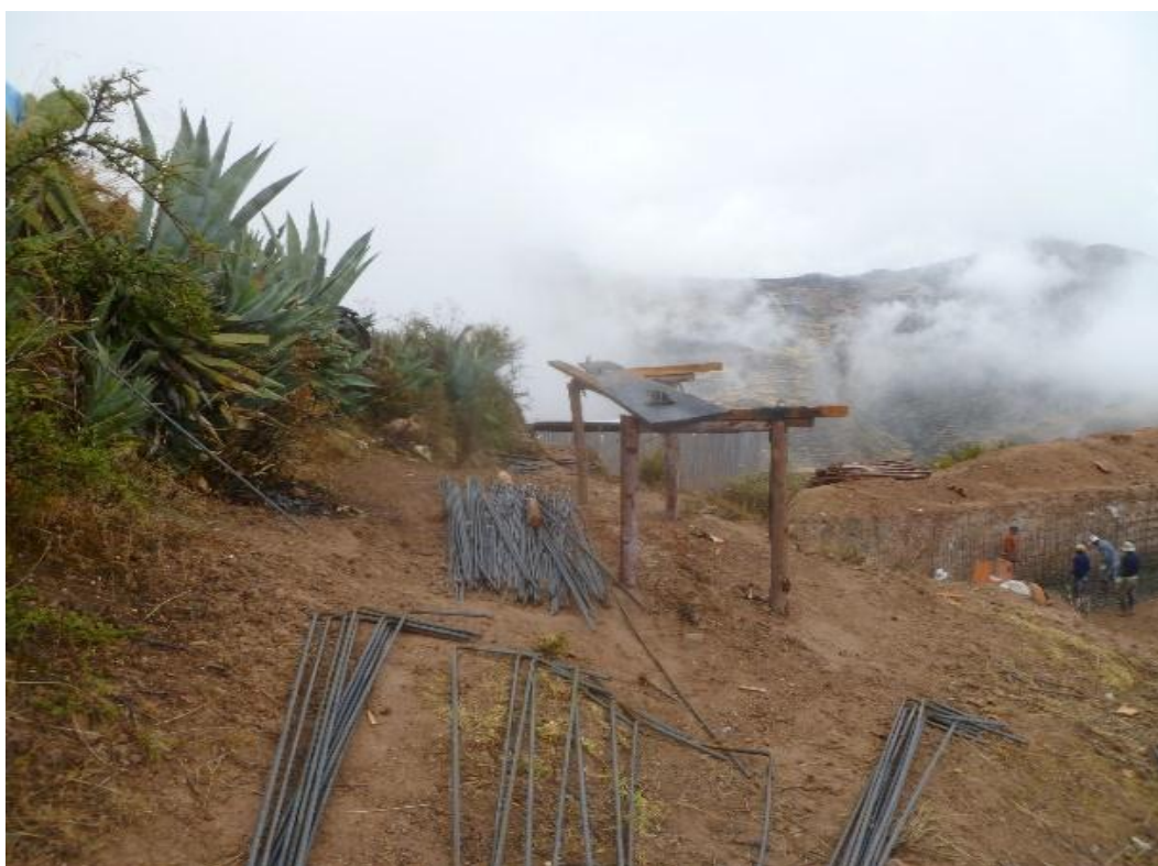
Corte de varillas de acero para zapata/ reservorio Erusco
