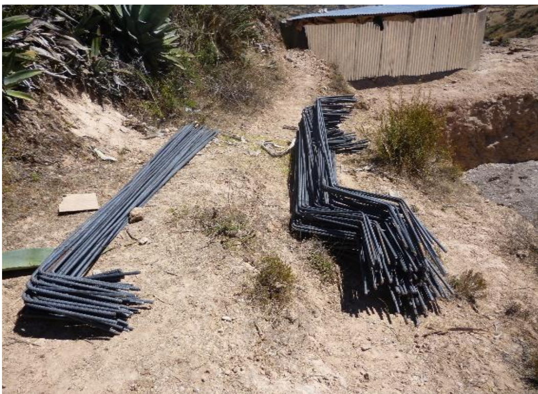
Cantidad de varillas de acero para zapata/ reservorio Larampuquio
