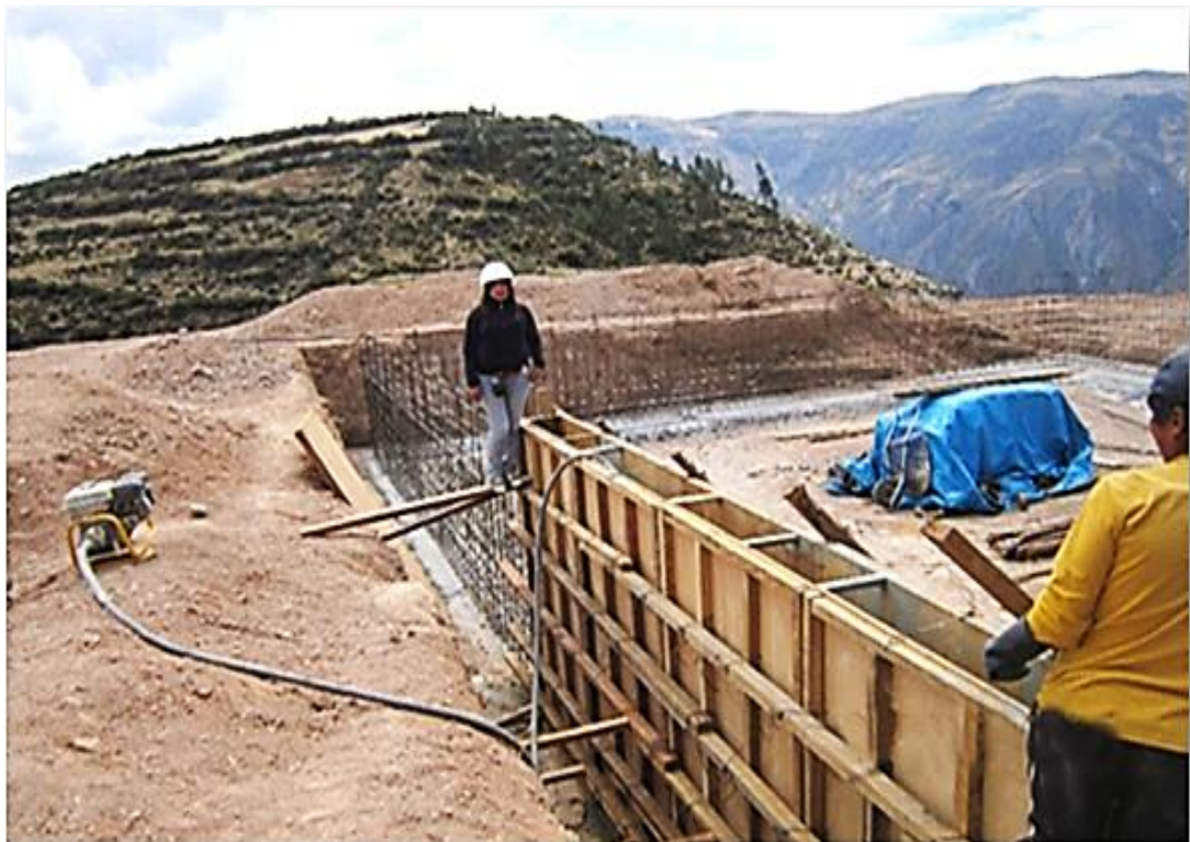
Midiendo el ancho de muro en el encofrado reservorio Erusco
