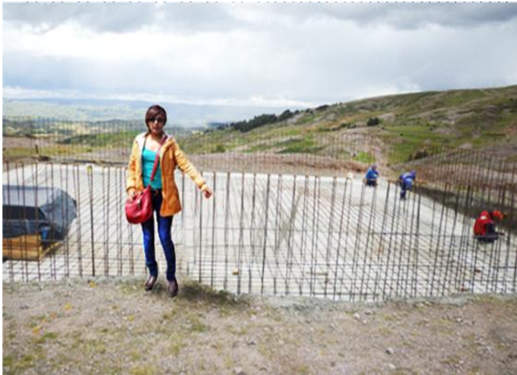
Habilitación de acero reservorio Larampuquio
