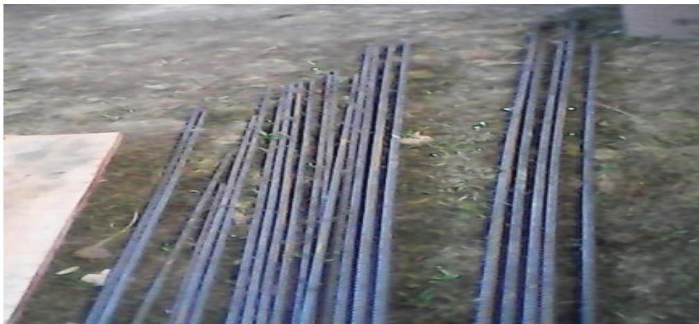
Figura Nº 21. Desperdicio de acero – reservorio Larampuquio
