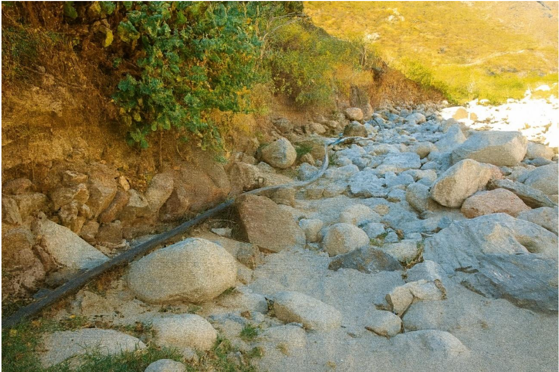
Cauce con piedras y tubería de conducción
