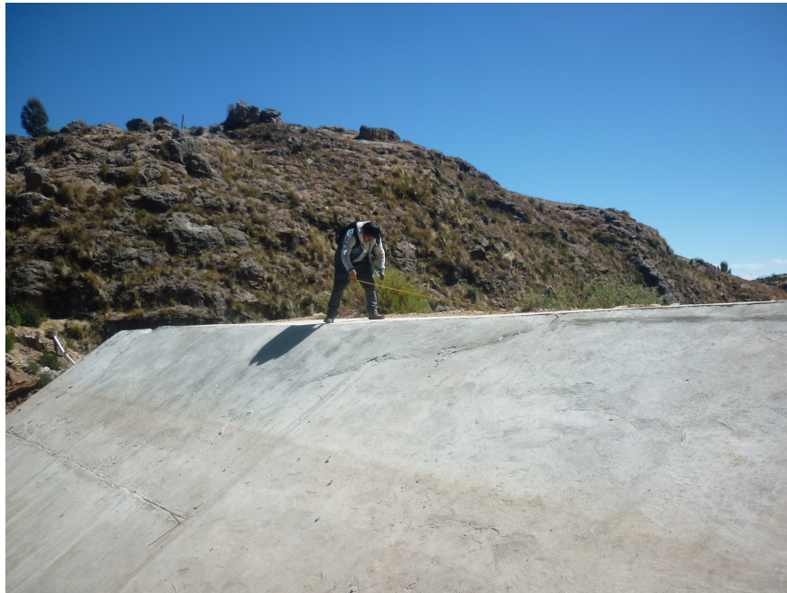
Figura A.4: Haciendo las mediciones de la corona de la presa. Fuente: Elaboración propia.
