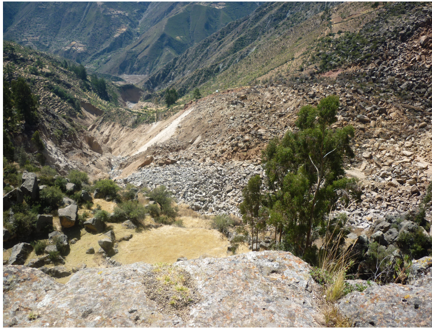
Figura A.12: Vista del deslizamiento de tierra en Ayaqchiri.
