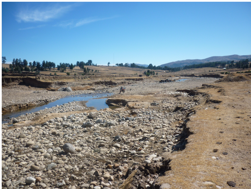
Figura A.7: Vista del recorrido de la crecida. Fuente: Elaboración propia.
