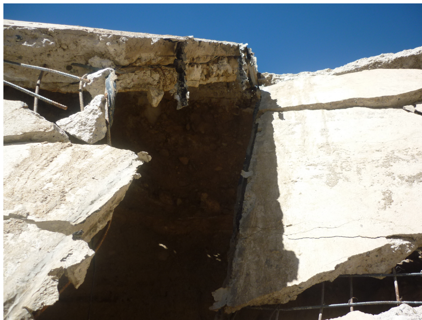
Figura 4.16: Uso de water stop y relleno asfáltico en forma parcial en las juntas de dilatación.
