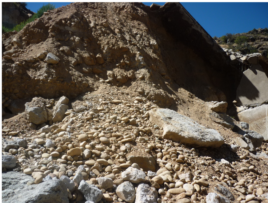
Figura 4.17: Vista actual del cuerpo de la presa.
