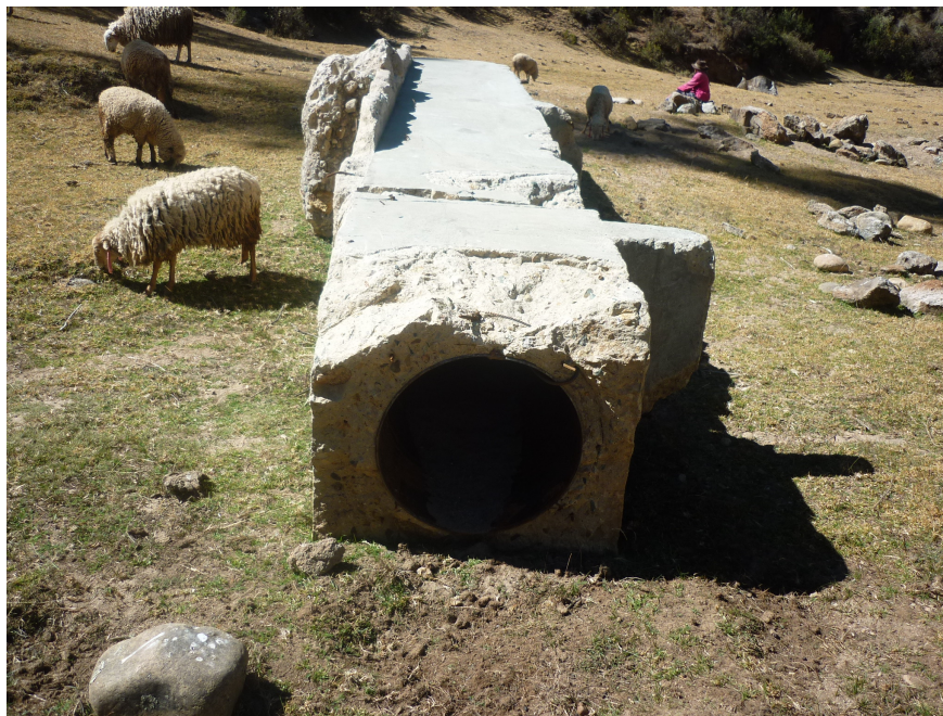
Figura 4.18: Vista de los restos de la tubería de servicio.
