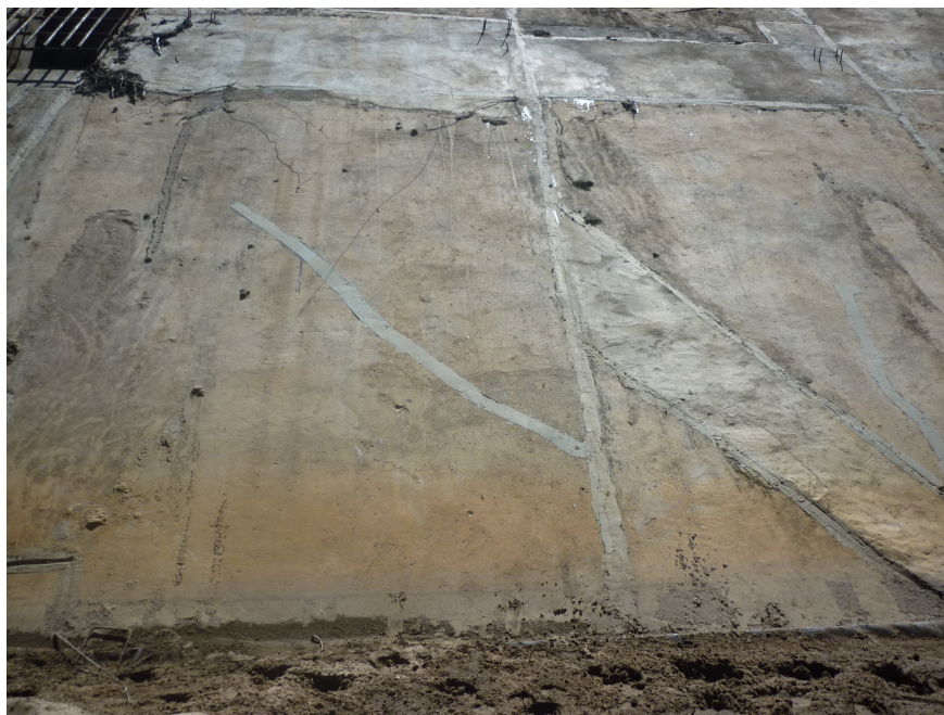
Figura 4.13: Imágenes de los agrietamiento sellados en la presa Tomacucho.
