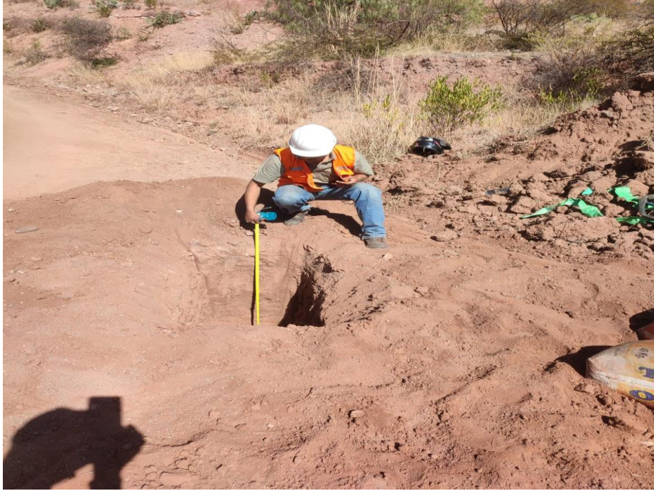
Excavación de calicatas de estudio
