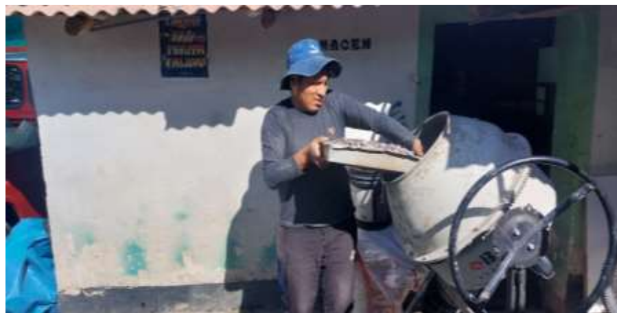
6.23. Vertido de los agregados de acuerdo a la dosificación
