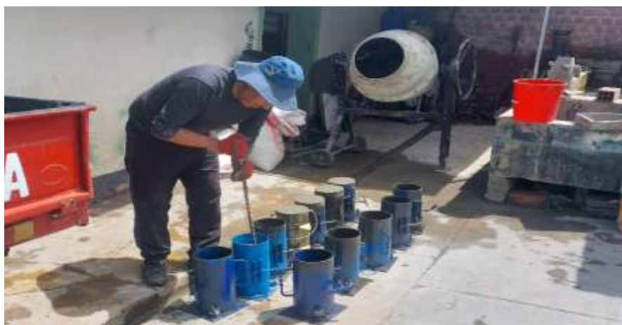
6.26. Llenado y varillado de las probetas de concreto
