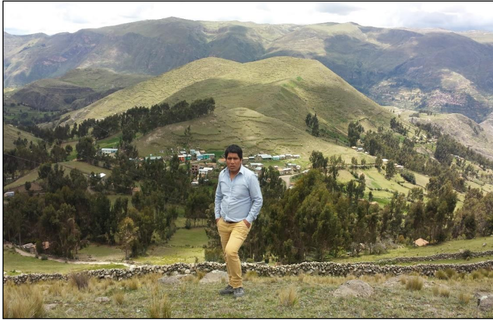
Figura 7. Vista panorámica del centro poblado de Casacancha, planeando y ubicando el reservorio proyectado y el PTAR Fuente: Elaboración propia
