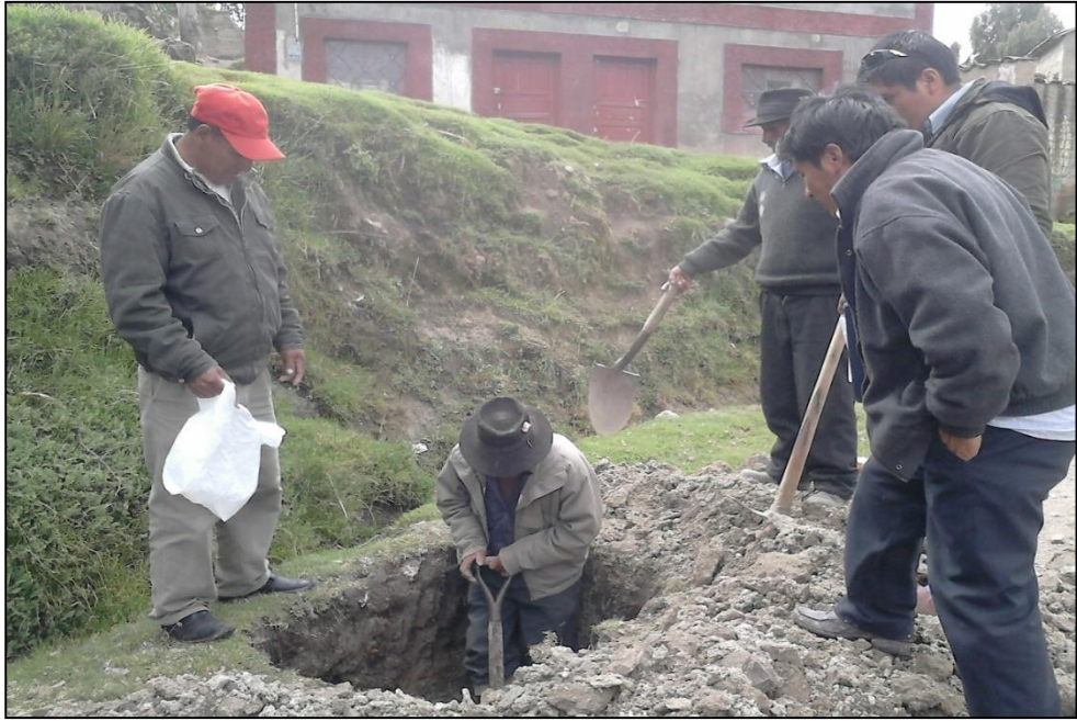
Figura 10. Calicata N° 30, en la línea de distribución y colector de alcantarillado, verificando el tipo de suelo Fuente: Elaboración propia
