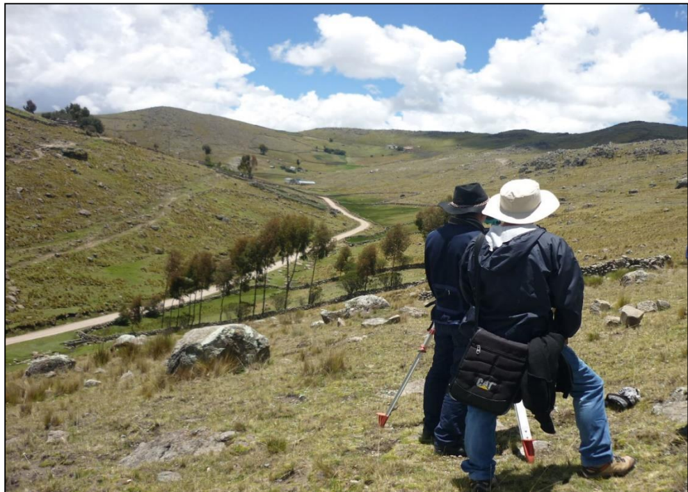
Figura 6. Colocación de BM. Y se continúa con los trabajos Fuente: Elaboración propia
