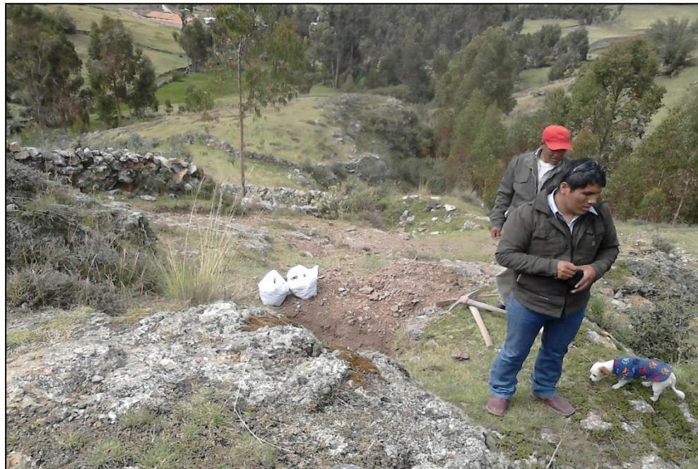
Figura 11. Calicata N° 34, en la proyección de Planta de Tratamiento de Aguas Residuales, verificando el tipo de suelo. Fuente: Elaboración propia
