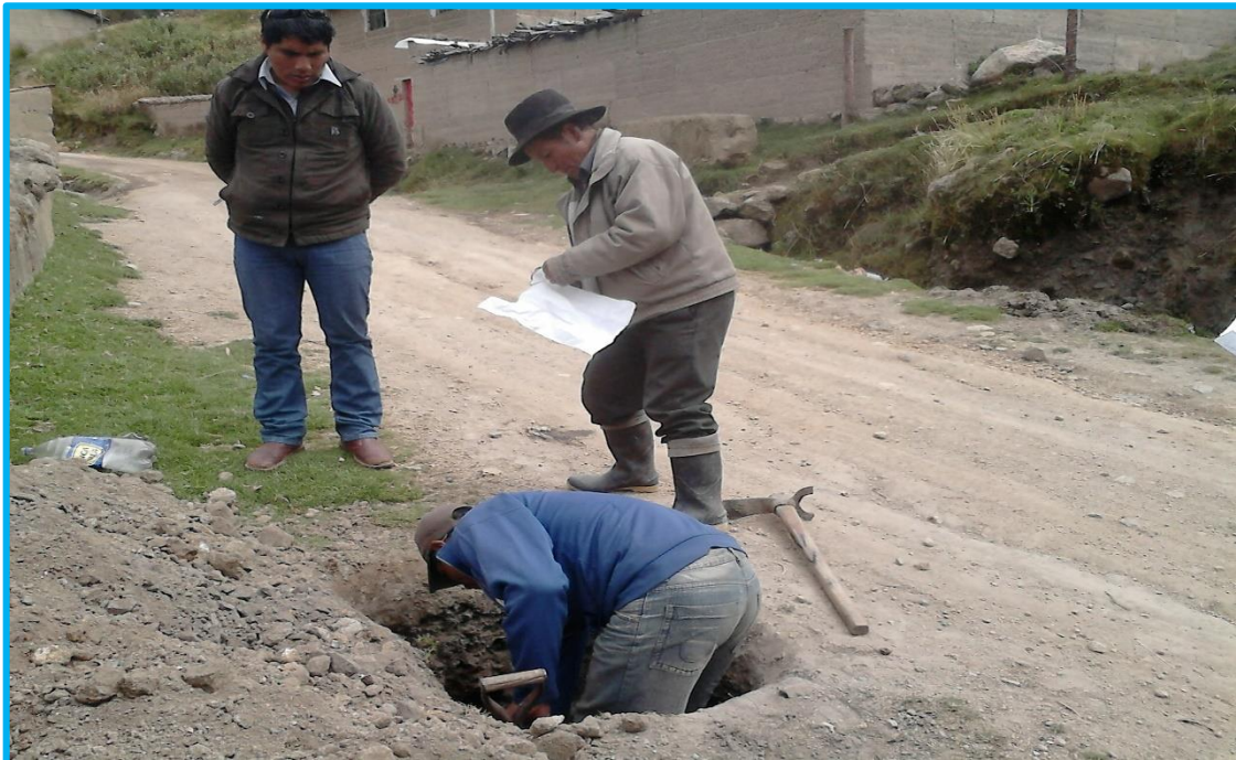
FOTO N° 02: ESTUDIO DE MECÁNICA DE SUELOS EN LÍNEA DE DISTRIBUCIÓN Y ALCANTARILLADO
